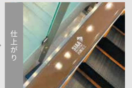
仕上がり コーティング剤が乾燥し光沢が出たら完成です。
