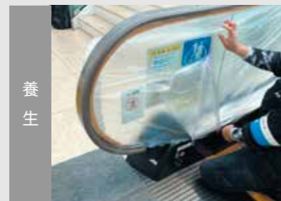
養生 移動手すり以外に洗浄液がつかないように養生を行います。
