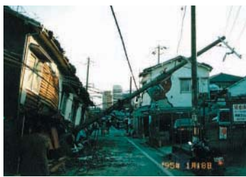
▲図2 阪神・淡路大震災における配電設備の被害(提供: 関西電力) 阪神・淡路大震災で倒壊家屋などが電柱に接触し、電柱が倒壊、折損、傾斜などの被害を受けた例。
