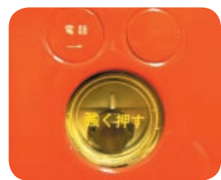
火災報知器 押しづらいようにカバーがかけてある
