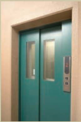
エレベーター・2階ホール。居住階のエレベーターには防犯窓付きドアが設けられている。
