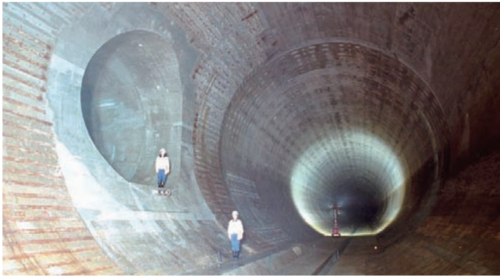
図1 神田川・環状七号線地下調節池（提供：東京都） 水害の多発する神田川中流域の洪水を予防するための地下調節池。神田川、善福寺川、妙正寺川という3つの川に洪水の危険があるときに、溢れた雨水を環状七号線の地下50mにある巨大トンネルに一時的に貯蔵する仕組みだ。
