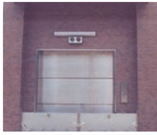
駐車場の防水板
