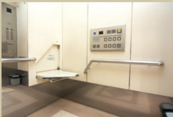
エレベーター・かご室内部。いすが設けられている
