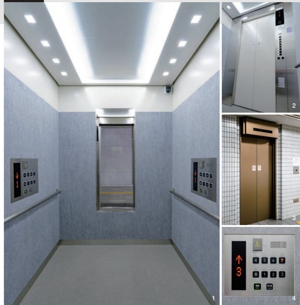
1. LED天井照明がかご室を明るく照らします。2,4. ユニバーサルデザインが採用されたかご室。3. 地下階の乗場ドアも一新。
