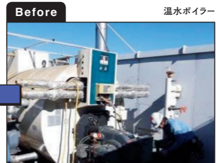
給湯システムをハイブリッド給湯システムに更新。
