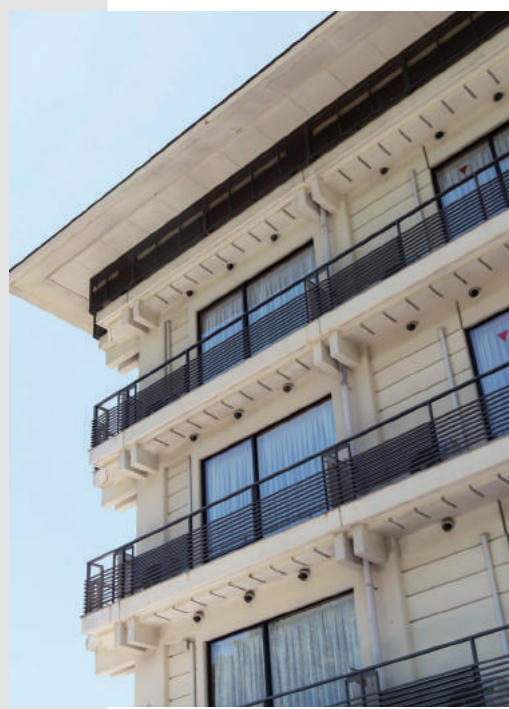
エアコンの室外機が外から見えにくくなるよう、欄干の格子の一部を改良して景観にも配慮。
