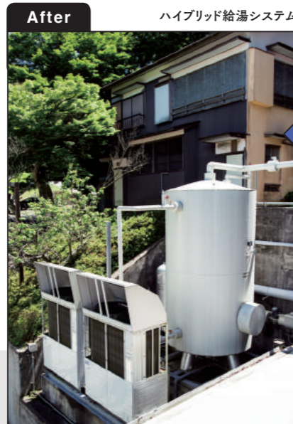
給湯システムをハイブリッド給湯システムに更新。
