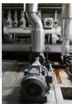
(左) 更新した冷温水ポンプ (右) 不要となった設備を撤去し、施設の保全とスペース確保にも貢献
