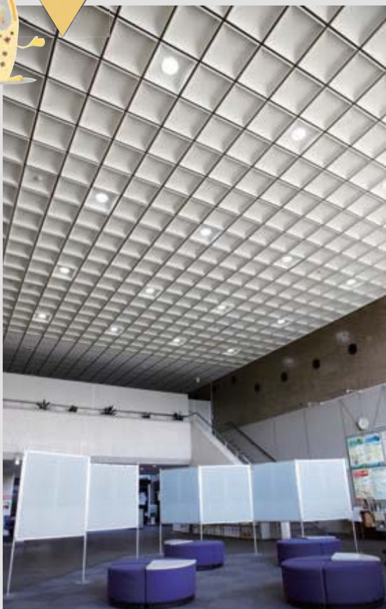
館内に入っすぐの共用部では、ダウンライト照明からLED高天井用ダウンライトに更新
