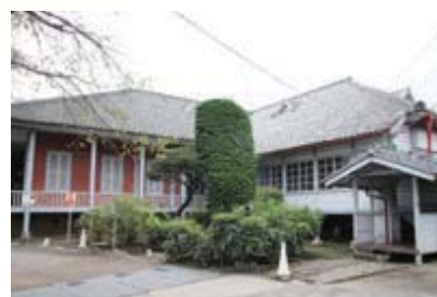
撮影協力: 富岡市・富岡製糸場
