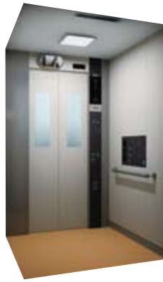
通常の操作盤と側面操作盤
