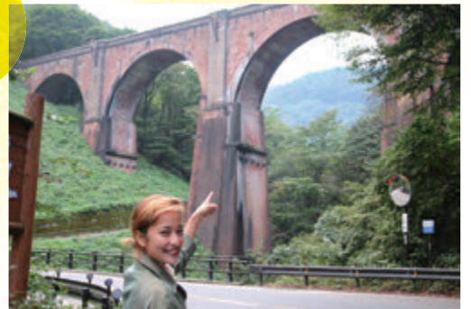
山道を登っていくと突然目の前に現れる巨大アーチ。絹を運んだ鉄道橋も今は、遊歩道になっているそうですが、あの高さはちょっと怖いかも。
