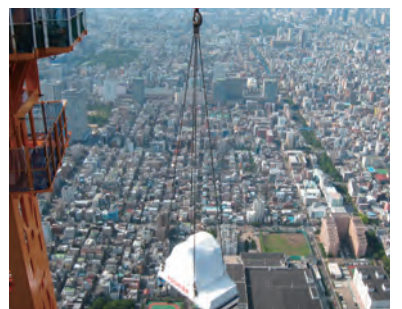
重さ20tの巻上機は、クレーンで持ち上げて 設置された。将来のリニューアルを見ずえて、 交換しやすいように設計されている。
