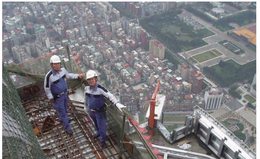
据付工事中に、93階の機械室の横で撮影された写真
