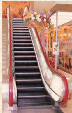
①エスカレーター1号機
