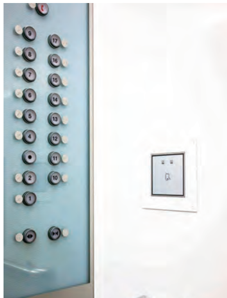
2015年にはカードキーを用いたセキュリティ機能が導入され、かご室の壁面にカードリーダーが設置された。
