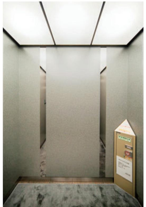
▲エレベーターのかご室内。正面に見えるのが、背面の壁に設置された、スリット状のステンレス製鏡。
