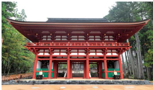
172年ぶりに再建された中門。今年4月2日に落慶法要が行われた。堂宮大工筆頭として尾上氏が再建の指揮を執り、鎌倉時代の建物が再現された。
