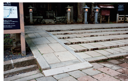
参道には、階段のある場所にこうしたスロープが適宜設置されている。写真は御廟橋手前のもの。景観になじむ自然なデザインだ。
