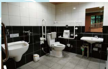
極楽橋駅のバリアフリートイレ。オストメイト（人工肛門や人工膀胱を持つ人）対応設備、大人用の多目的シートなどが完備されている。
