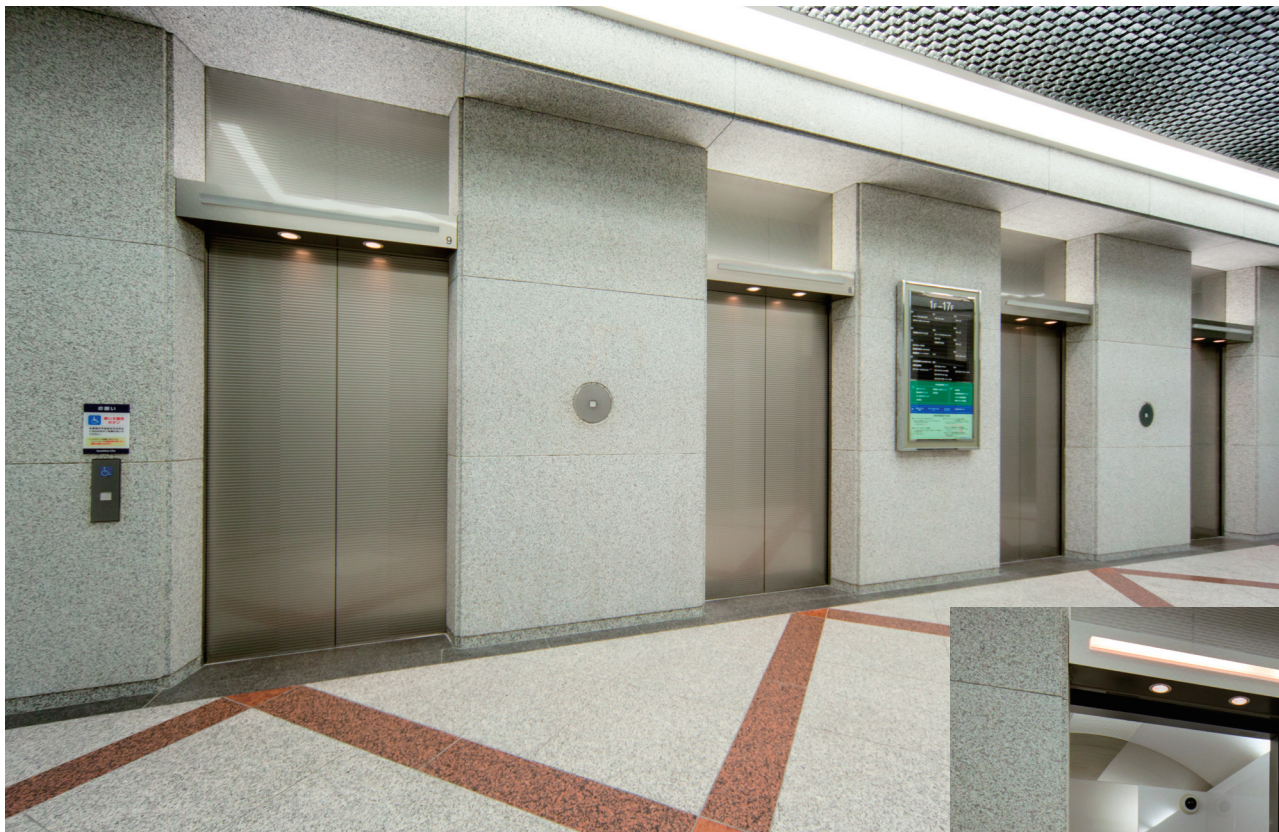
▲エレベーターは群管理システムによって制御され、効率的な運行管理がされている。
