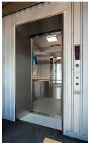
バリアフリー化の一環で駅に設置されたエレベーター。停電時でも最大2時間の継続運転が可能タイプだ。
