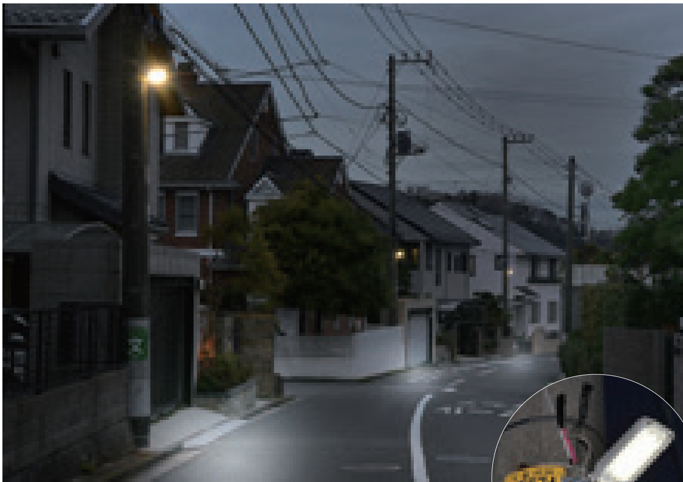
防犯灯のLED化が完了した街並み。東芝ライテック製のLED防犯灯が夜道をしっかり照らしている。
