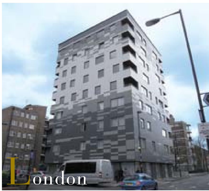
▲海外の事例 ロンドンに2009年に竣工した9階建て集合住宅。構造材としてCLT（※4）が用いられている。欧州では近年、CLTを利用した中高層建築が次々と建てられている。
