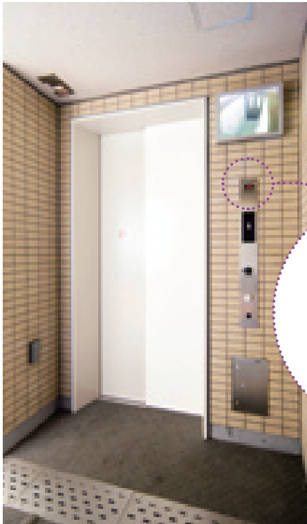
マンション1階のエレベーター乗り場。ニーズに合うようから設計し、各階に設置された蓄電池残量計により、蓄電状況がリアルタイムでわかる。
