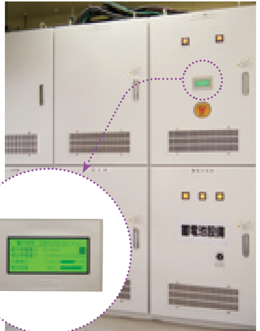
リチウムイオン蓄電システムの本体。平常時は夜間でも、停電時に備えて蓄電残量が50%を切らないようにする等、様々な制御が可能。蓄電量はモニターで一目瞭然。
