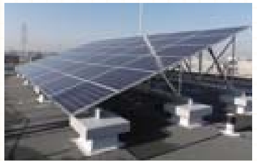
屋上に設置された太陽光パネル
