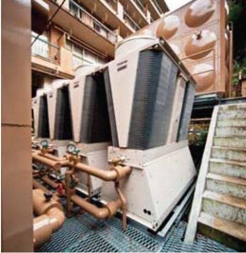
上/ 川の上にCAONSを設置するため、足場から施工した。 下/ 横から見たCAONS。
