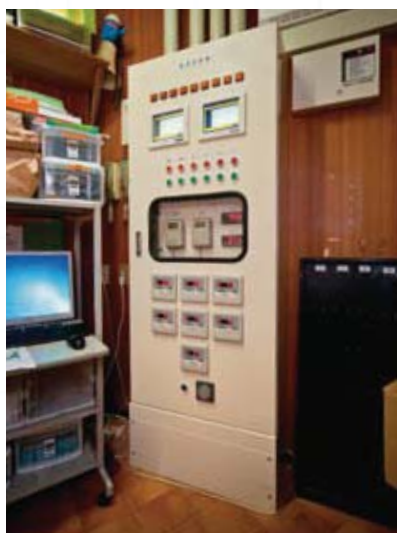
空調を管理する「空調コントロールユニット」。
