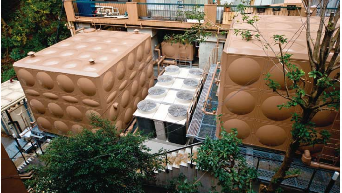
大浴場から客室風呂まで、お湯の温度を60℃に保つ循環加温ヒートポンプ「CAONS(カオンス)」。
