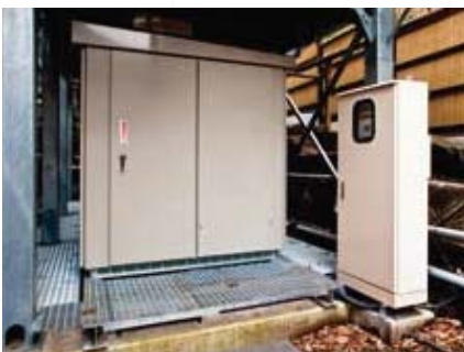
CAONS導入に伴い、キュービクル(高圧で受電した電気の電圧を下げる設備)も設置した。
