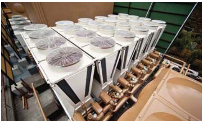
本館用の空調設備。
