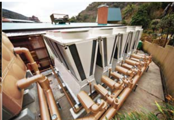
別館用の空調設備。
