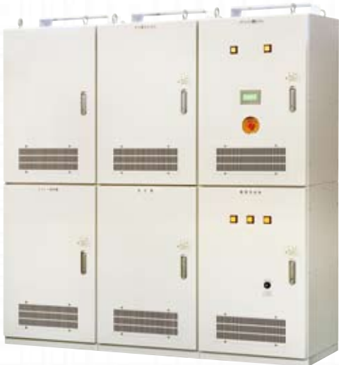
さらなる安全を期すために、蓄電池システムの導入も決定。
