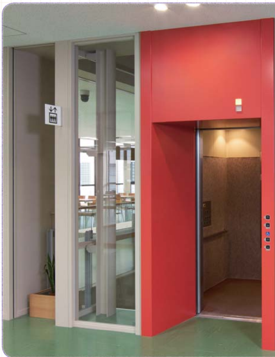
23号館(講義棟)エレベーター・2階のりば 同大学では、施設計画時に安全・安心を最優先にしているほか、昇降路をガラス製にすることでエレベーターの構造が外からわかりやすくなっている。
