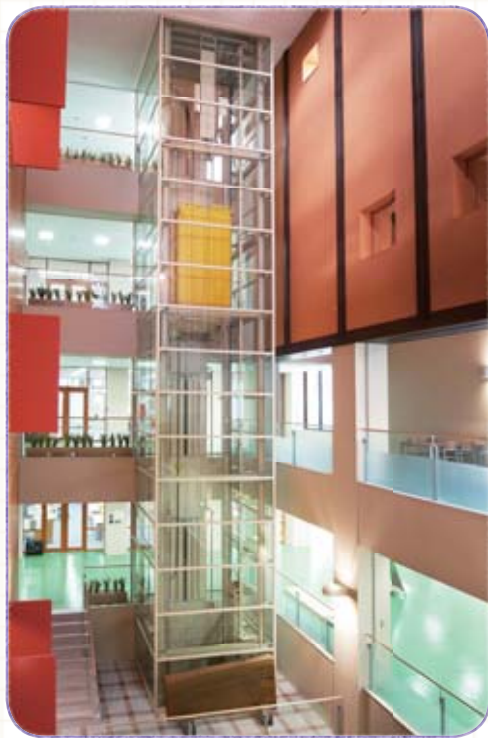
23号館エレベーター・昇降路背面側
