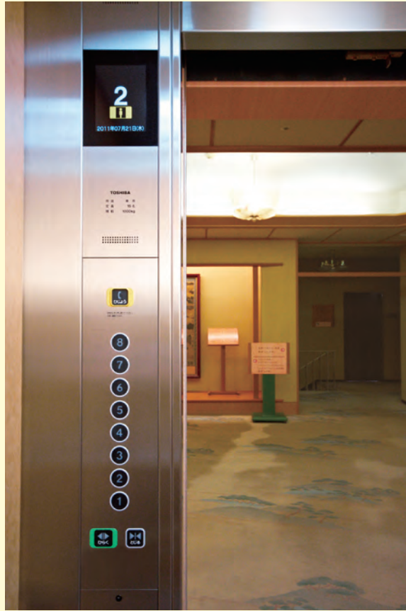
1階のりばとかご室操作盤 操作盤はユニバーサルデザイン対応で文字が見やすくなった。また、現在位置は液晶表示に変わり、上の帯板からなくなった。
