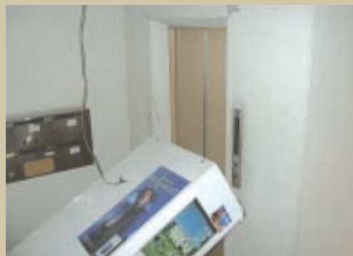
エレベーターホール周辺の倒壊
