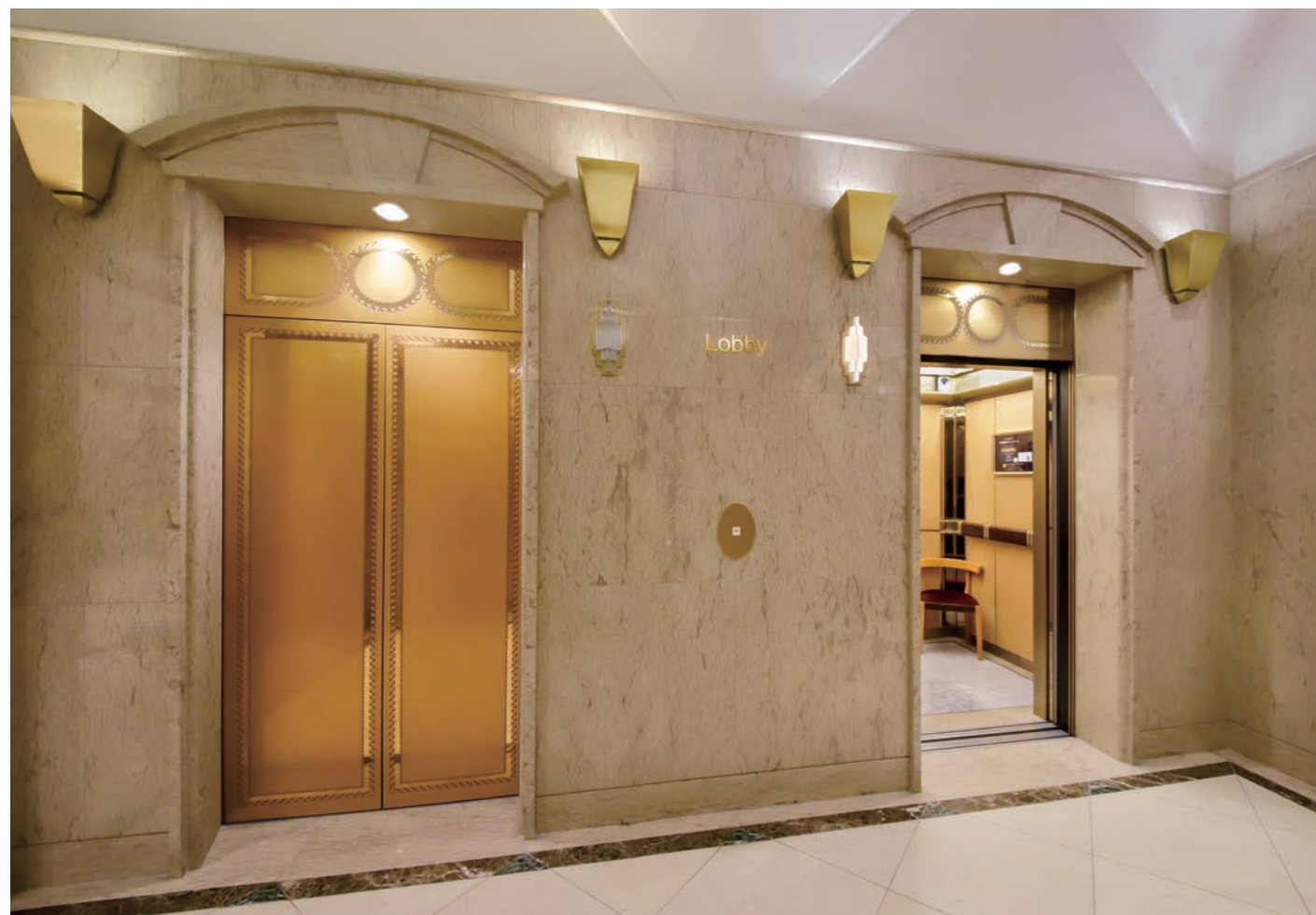
乗用20人乗りエレベーター・1階(既製品のりばドアを弊社工場にて新しいドアシステムに組み込み) リニューアル後
