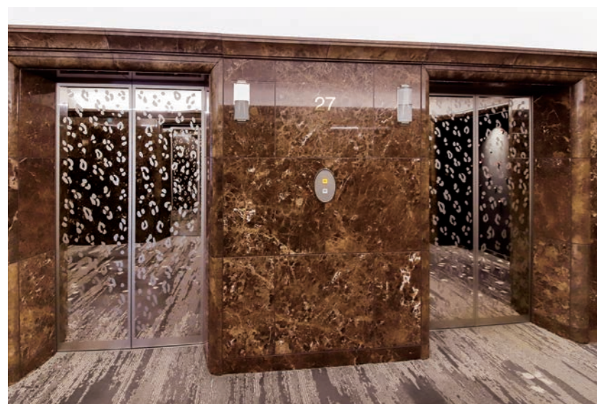
乗用20人乗りエレベーター・27階(既製品のりばドアを弊社工場にて新しいドアシステムに組み込み) リニューアル後
