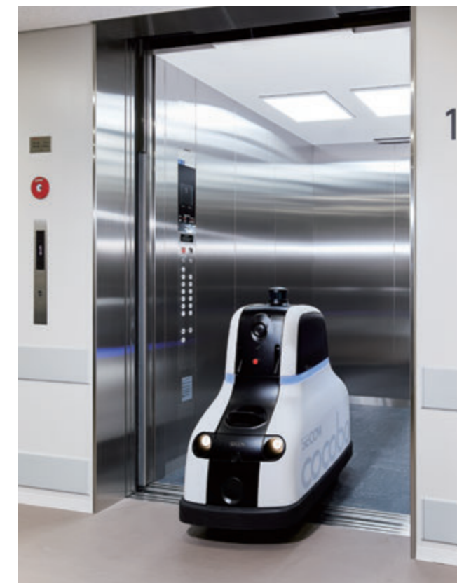
人荷用30人乗りエレベーター・南館1階 (東芝エレベータークラウドサービス エルクラウド ロボット連携サービス)
