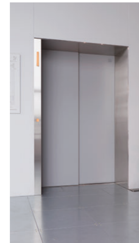
人荷用(展望用)18人乗りエレベーター・2階(NOVARE Academy)
