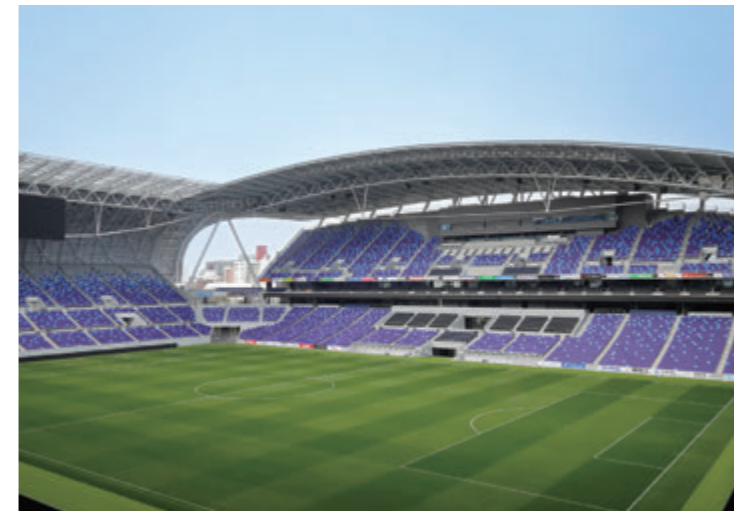
建物外観(スタジアム)
