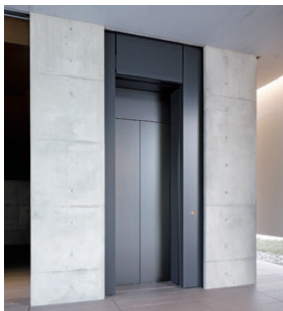
人荷用(兼非常用)26人乗りエレベーター・1階(NOVARE Archives)
