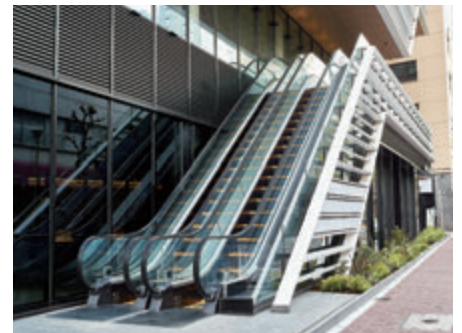
エスカレーター・1階
