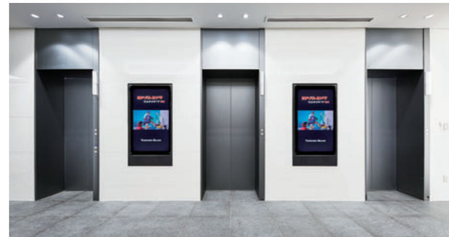
乗用23人乗りエレベーター・3階ホール(オフィス)
