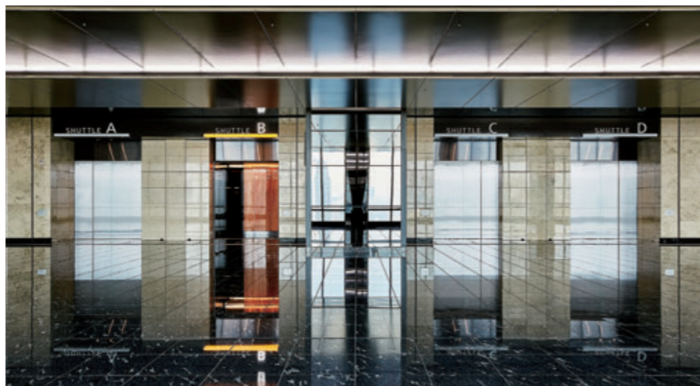
乗用75人乗りシャトルエレベーター・27階ホール
