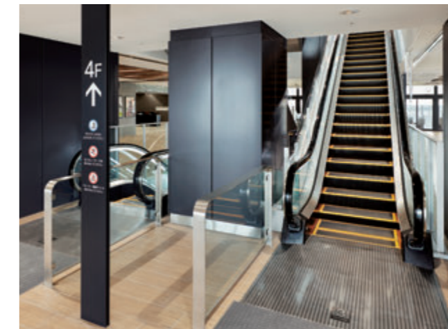
エスカレーター・3階
