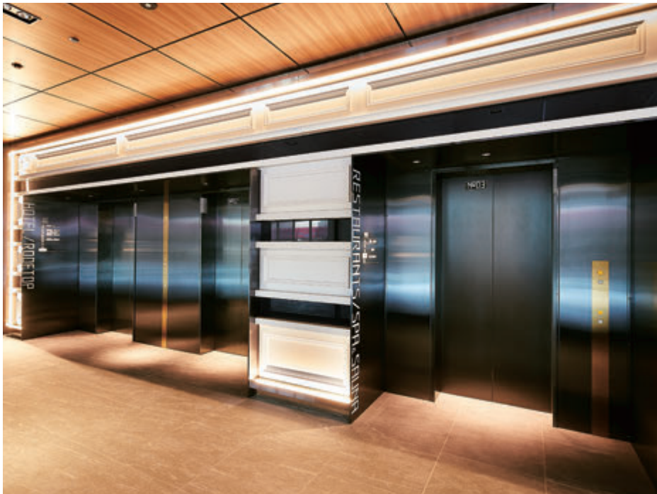
乗用17人/15人乗りエレベーター・1階ホール
