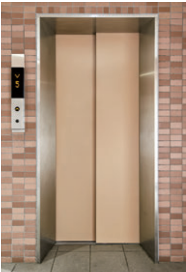
住宅用9人乗り(トランク付)エレベーター・1階ホール(リニューアル後)
