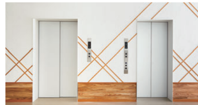
乗用20/13人乗りエレベーター・3階ホール（壁面：たかはら材の桧（県北産材））
