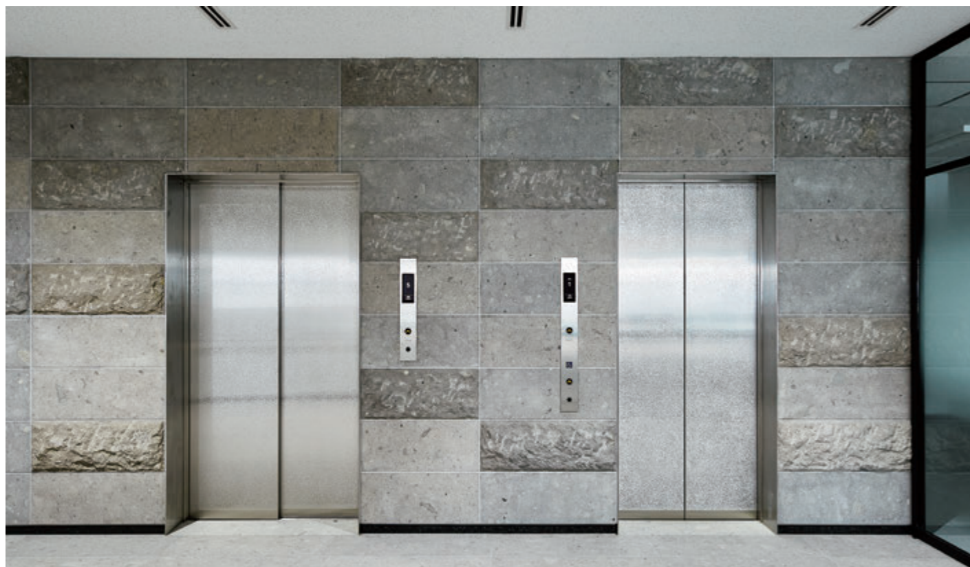
乗用20/13人乗りエレベーター・1階ホール（壁面：芦野石（県北産材））
