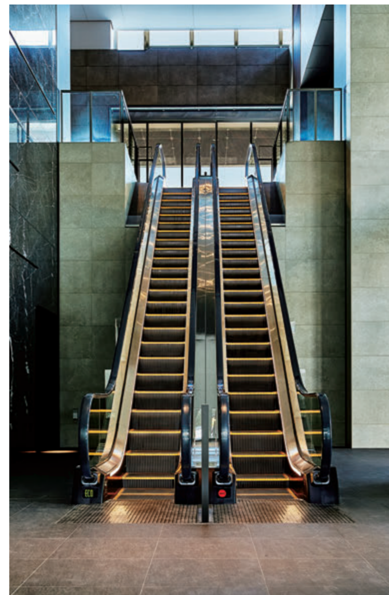
エスカレーター・1階
