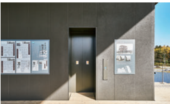
乗用11人乗りエレベーター・2階のりば(展望デッキ)
