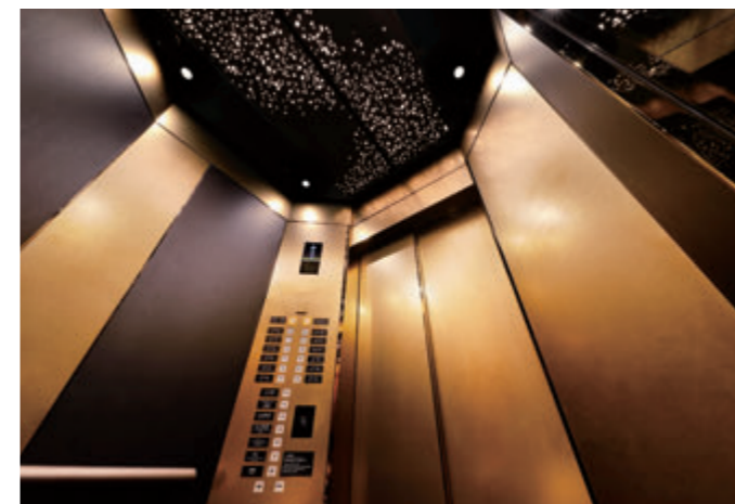
乗用(展望用)15人乗りエレベーター・かご室天井(リニューアル後)
