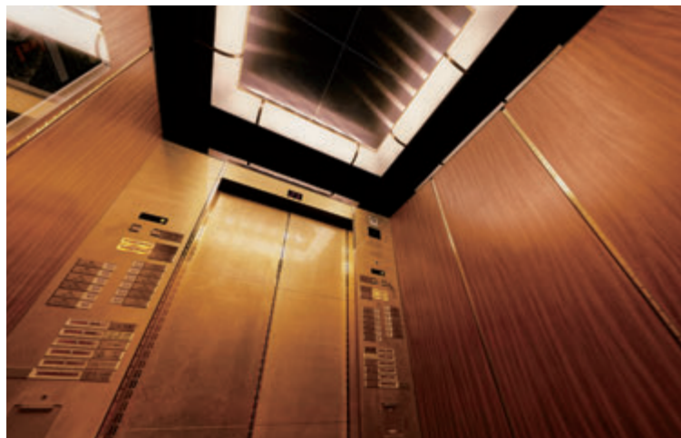
乗用20人乗りエレベーター・かご室天井(リニューアル前)
