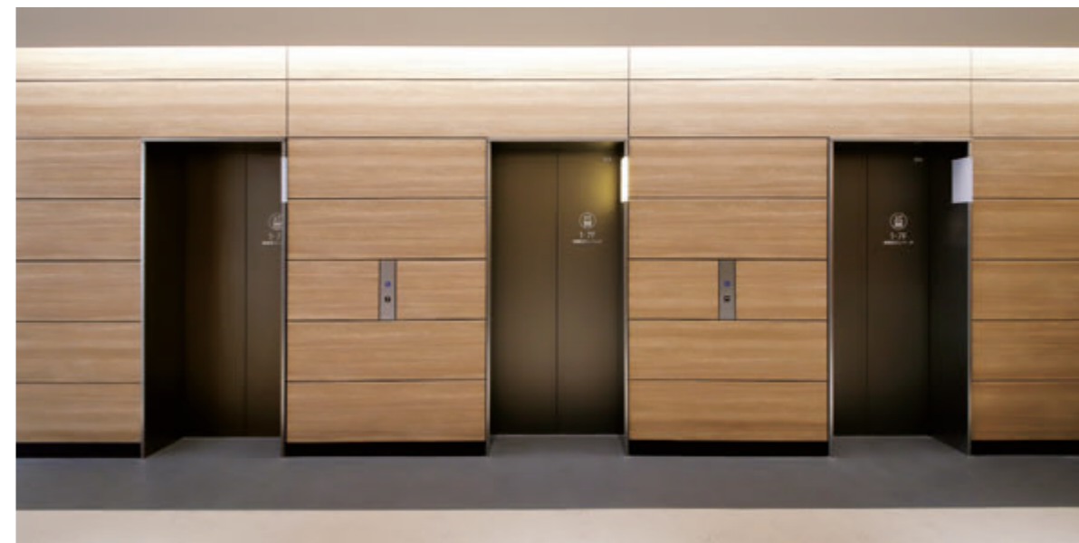
乗用15人乗りエレベーター・1階ホール
