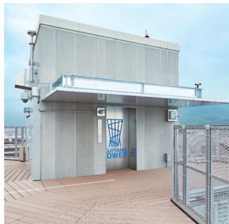
乗用24人乗りエレベーター・展望デッキ
