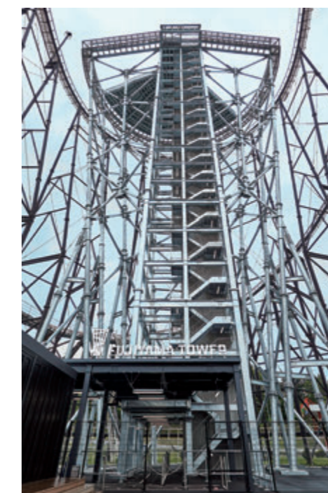
FUJIYAMAタワー（昇降路）
