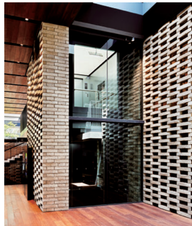
乗用(展望用)26人乗りエレベーター・昇降路
