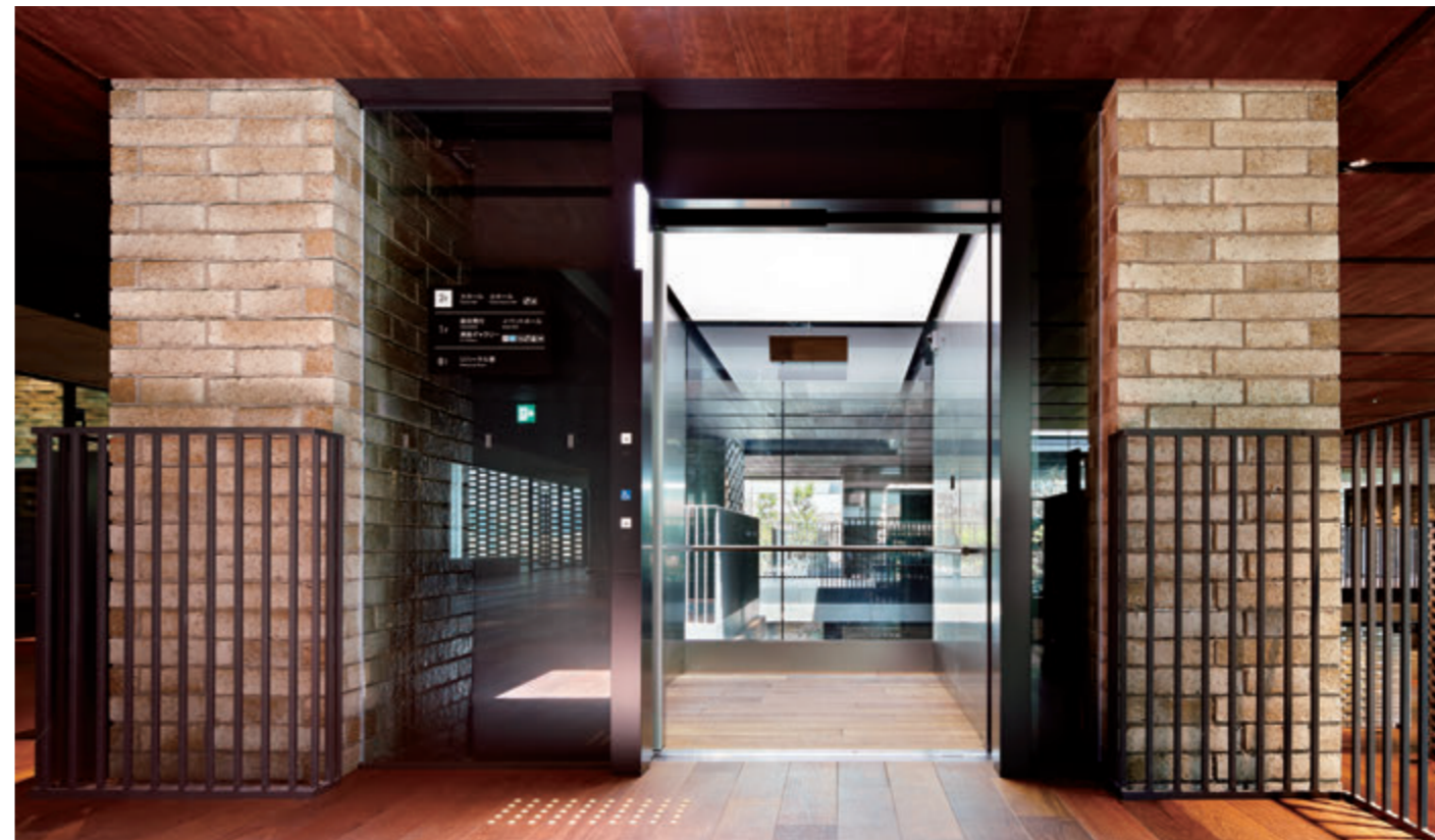
乗用(展望用)26人乗りエレベーター・2階ロビー
