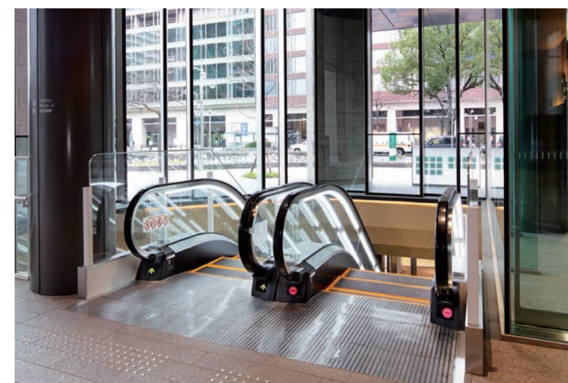
エスカレーター・1階
