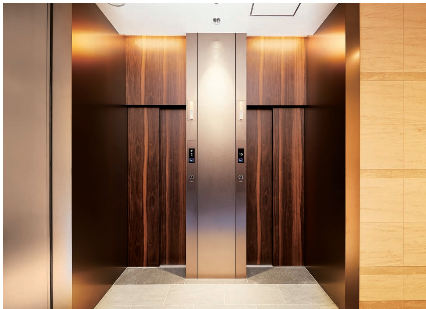
乗用13/9人乗りエレベーター・2階エレベーターホール
