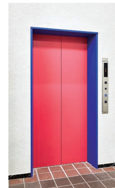
乗用11人乗りエレベーター・1階ホール
