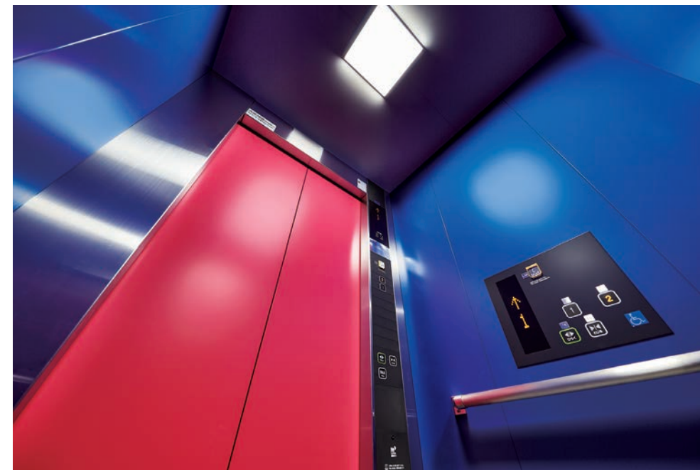
乗用11人乗りエレベーター・かご室天井
