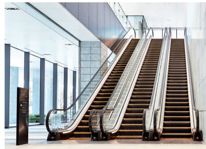
エスカレーター・1階
