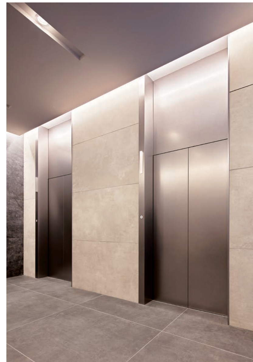
乗用20人乗りエレベーター・1階エレベーターホール
