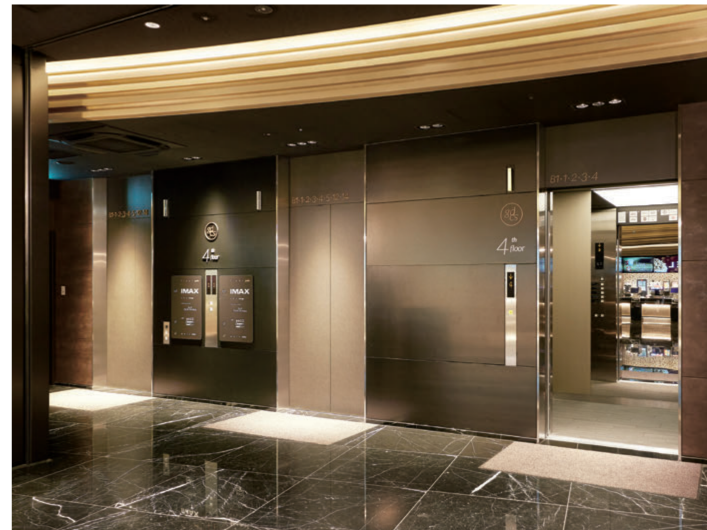
乗用24人乗りエレベーター・4階エレベーターホール
