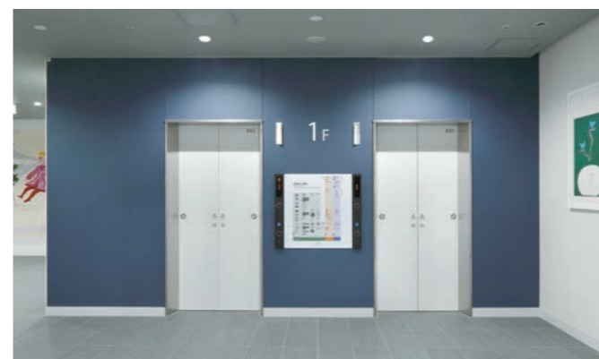
乗用15人乗りエレベーター・1階エレベーターホール
