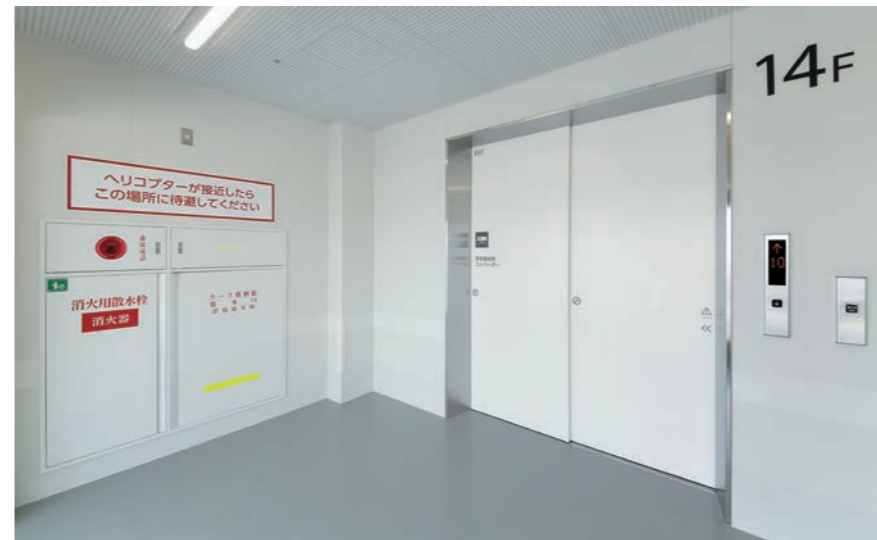
人荷用55人乗りエレベーター・14階屋上ヘリポート エレベーターホール
