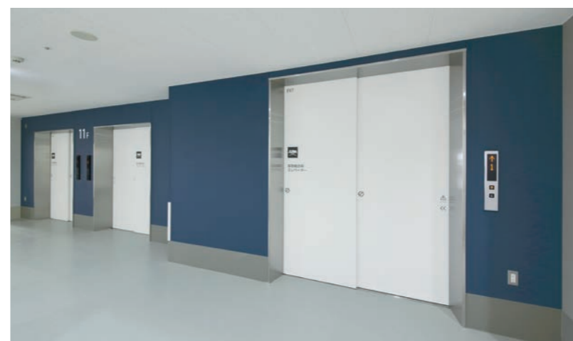
寝台用20人乗り/人荷用55人乗りエレベーター・11階エレベーターホール
