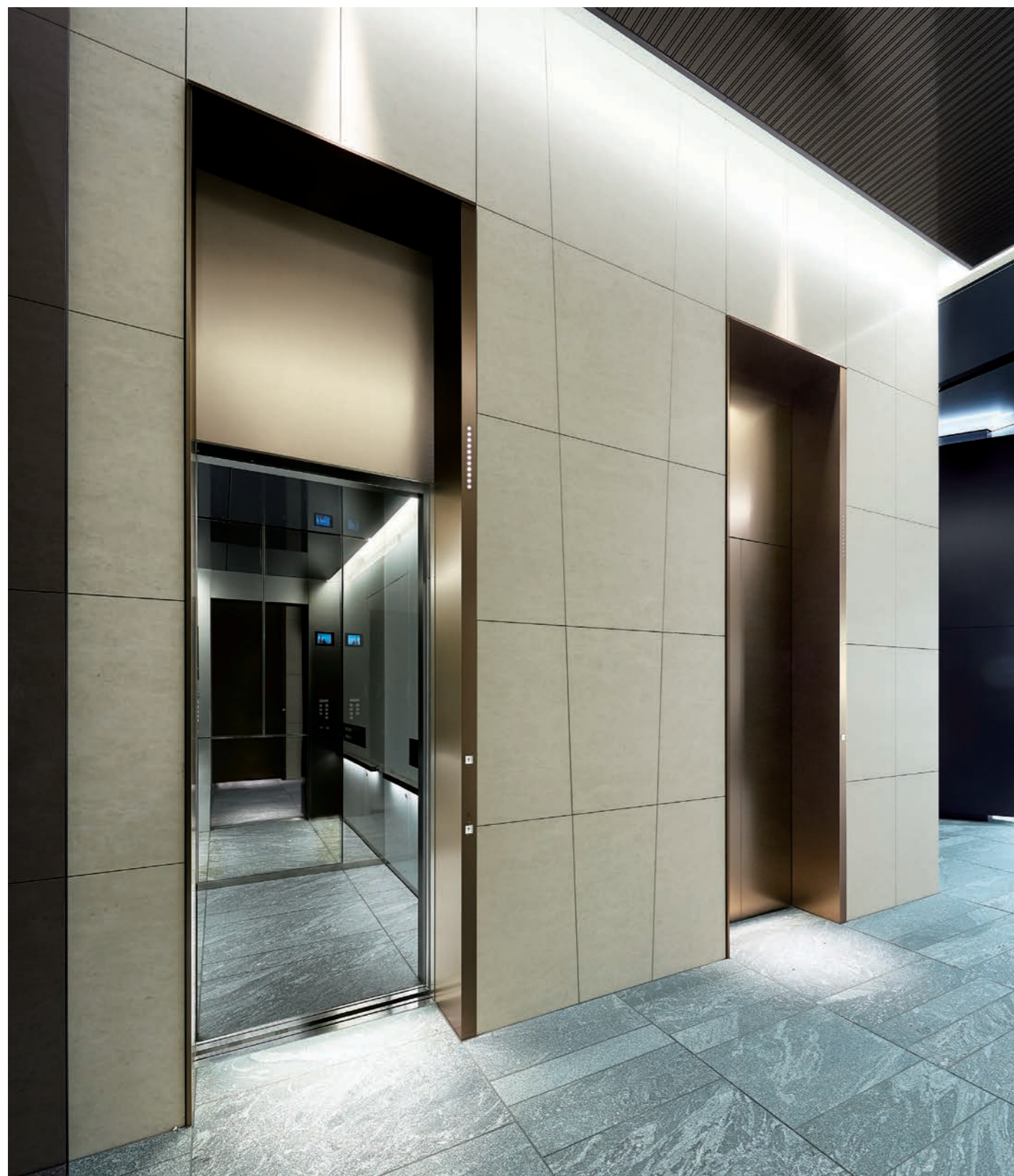
乗用24人乗りエレベーター・2階エレベーターホール
