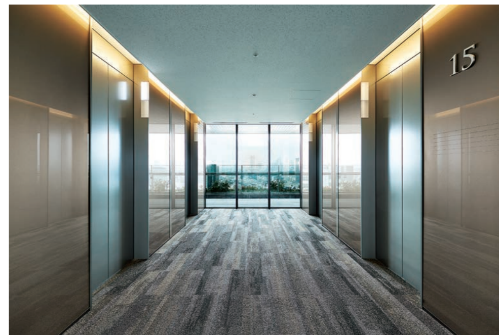
乗用24人乗りエレベーター・15階エレベーターホール
