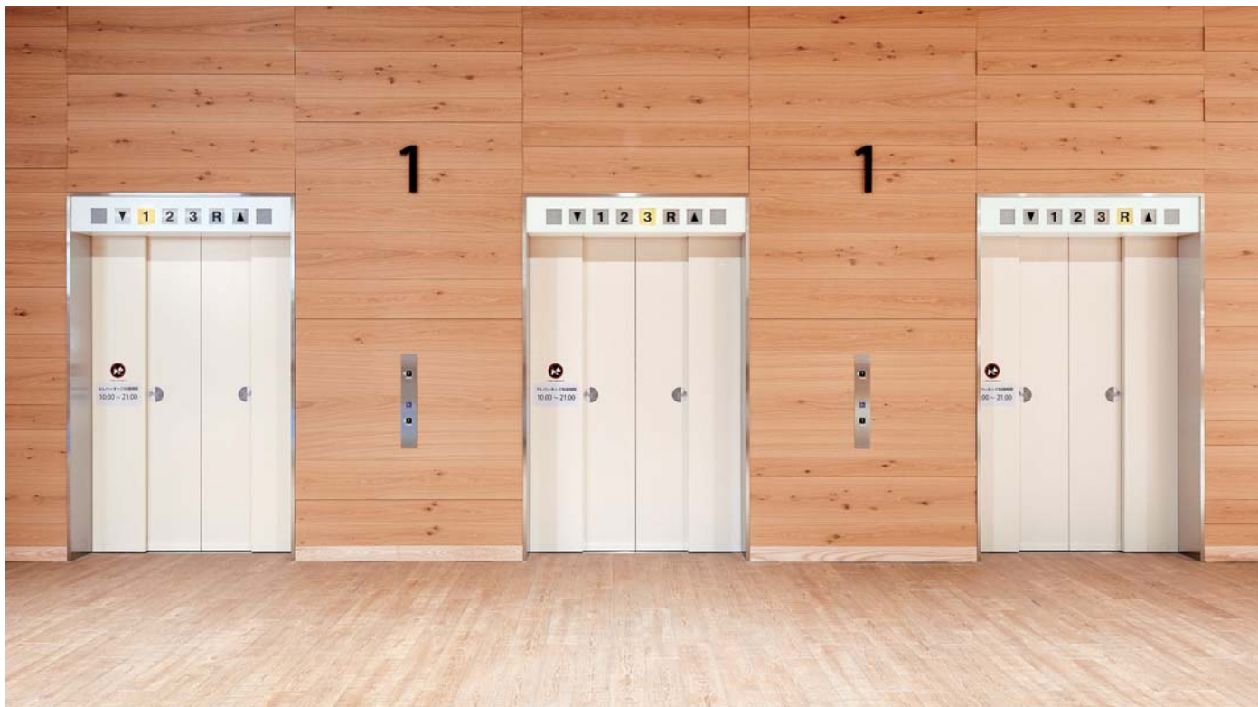
乗用24人乗りエレベーター・1階ホール
