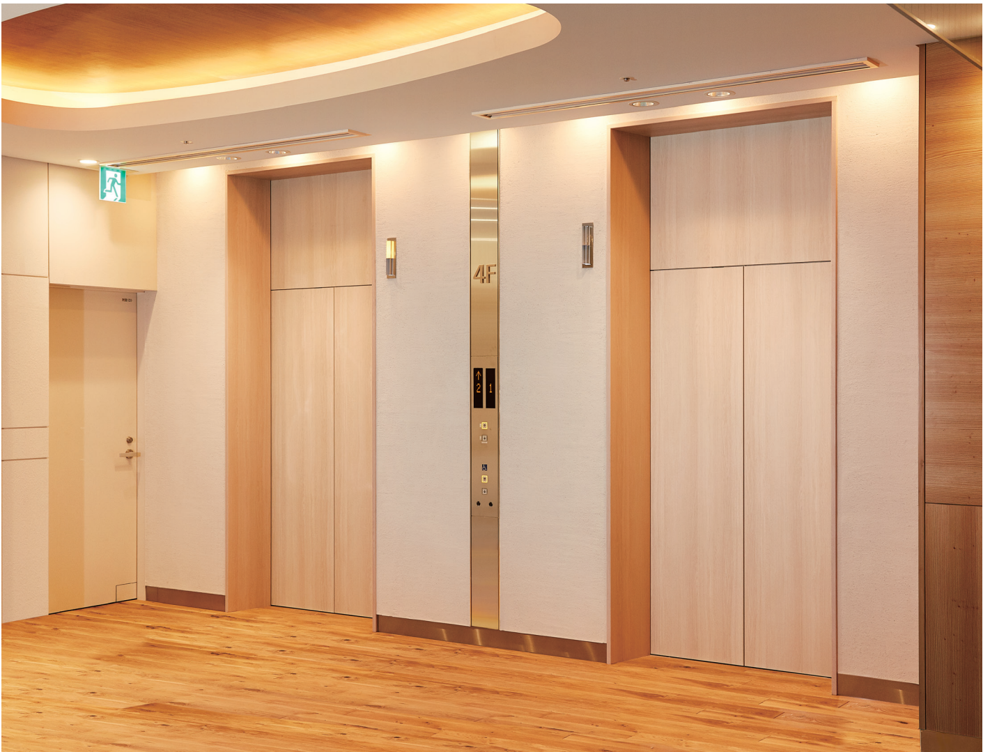
乗用24人乗りエレベーター・4階ホール
