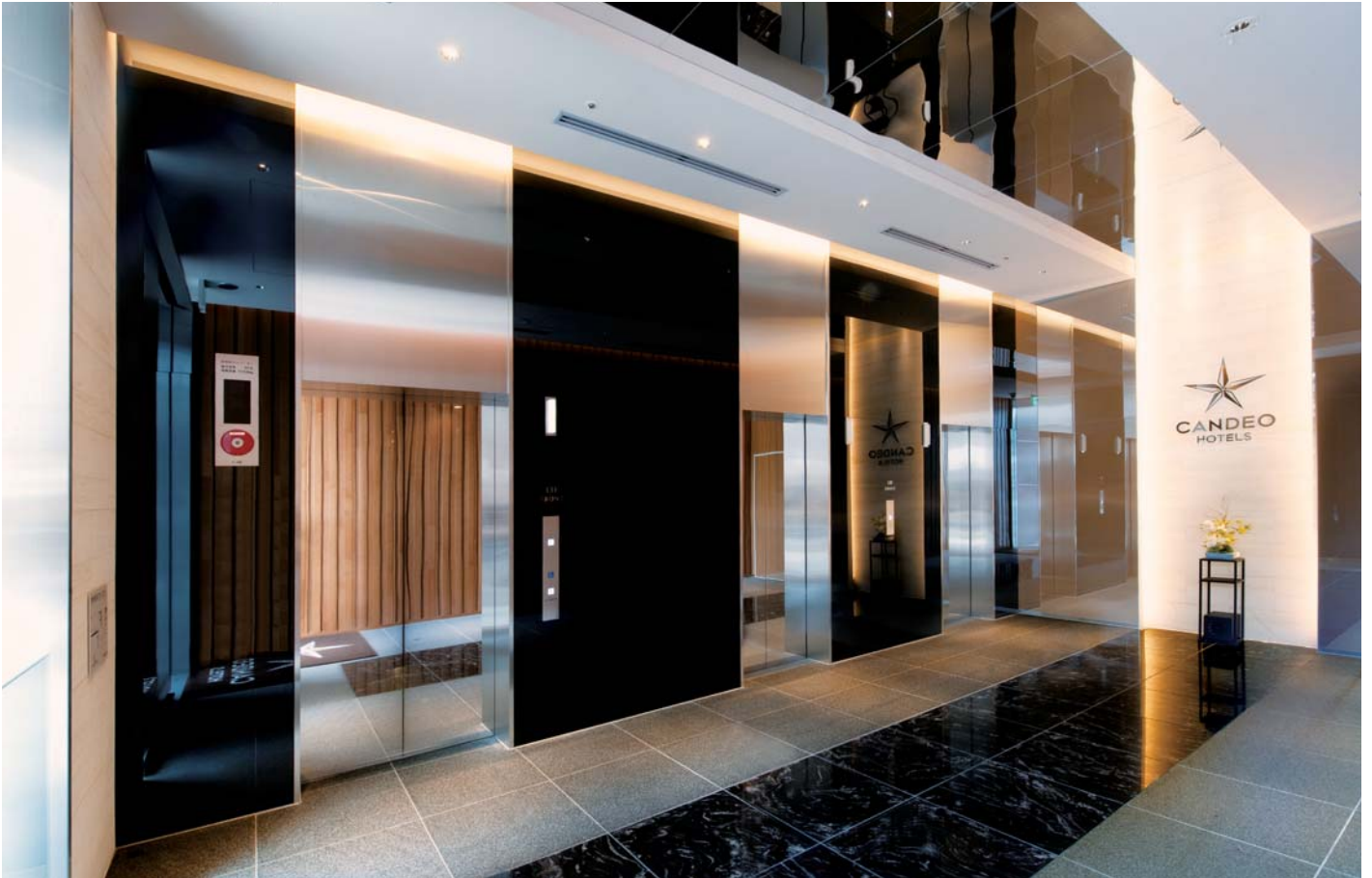
乗用(非常用)17人乗りエレベーター／乗用15人乗りエレベーター・1階ホール(カンデオホテルズ松山大道)
