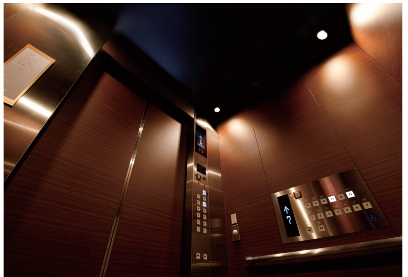
乗用(非常用)17人乗りエレベーター・かご室天井 (カンデオホテルズ松山大街道)
