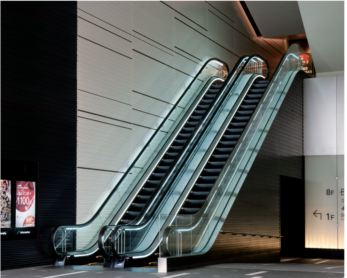
エスカレーター・エントランス(TOHOシネマズ 新宿)
