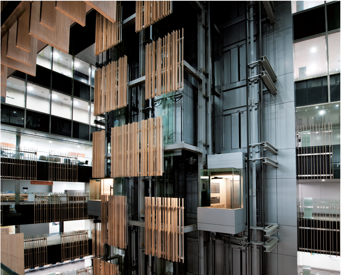
展望用20人乗りエレベーター／乗用23人乗りエレベーター・昇降路
