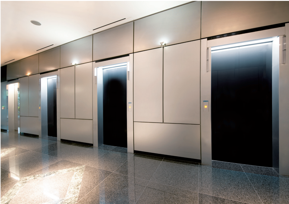
乗用24人乗りエレベーター・1階ホール(奥の1台がリニューアル前)
