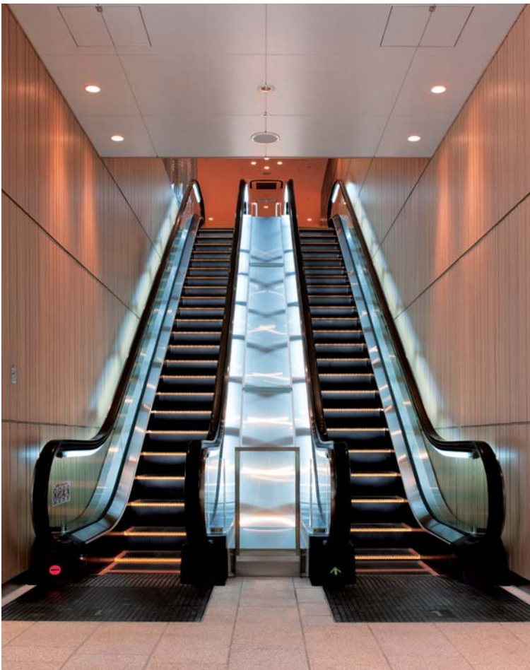
エスカレーター・エントランス(アエル松山)
