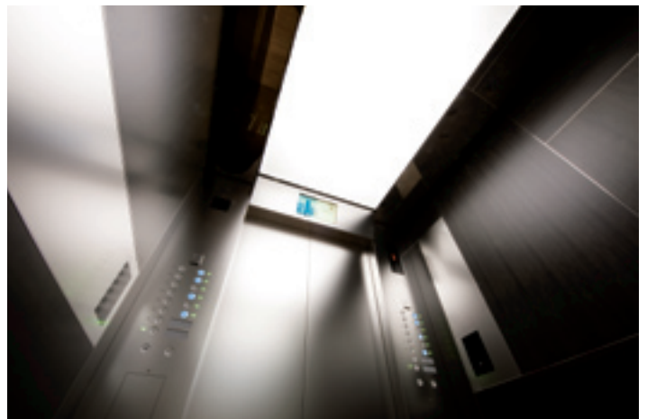
乗用24人乗りダブルデッキエレベーター・かご室天井
