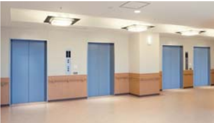
乗用15人乗り／寝台用15人乗りエレベーター・1階ホール
