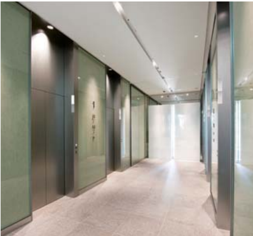
乗用20人乗りエレベーター・1階ホール
