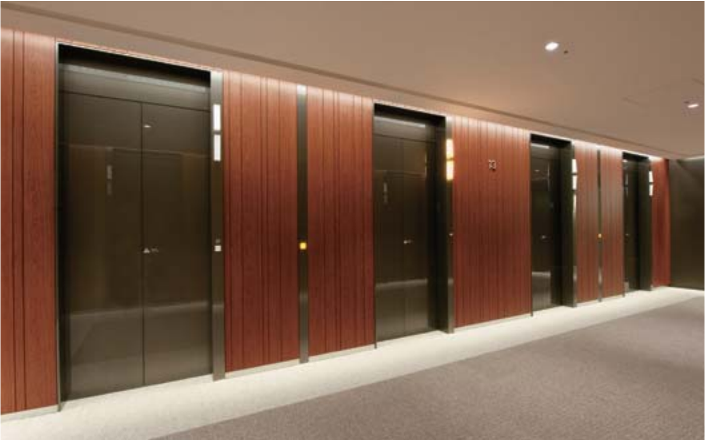
乗用27人乗りエレベーター・13階ホール
