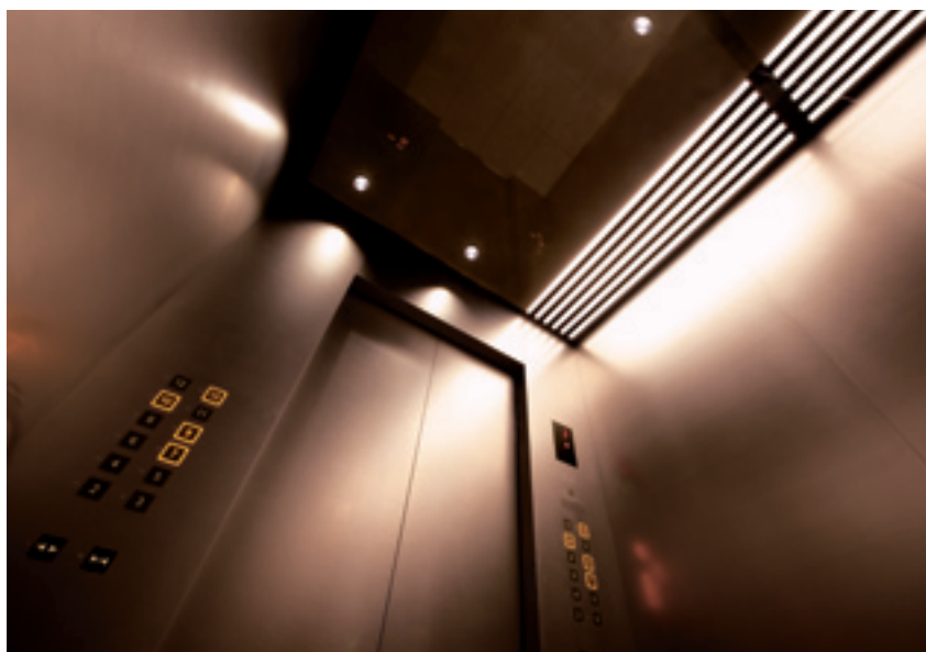
乗用27人乗りエレベーター・かご室天井
