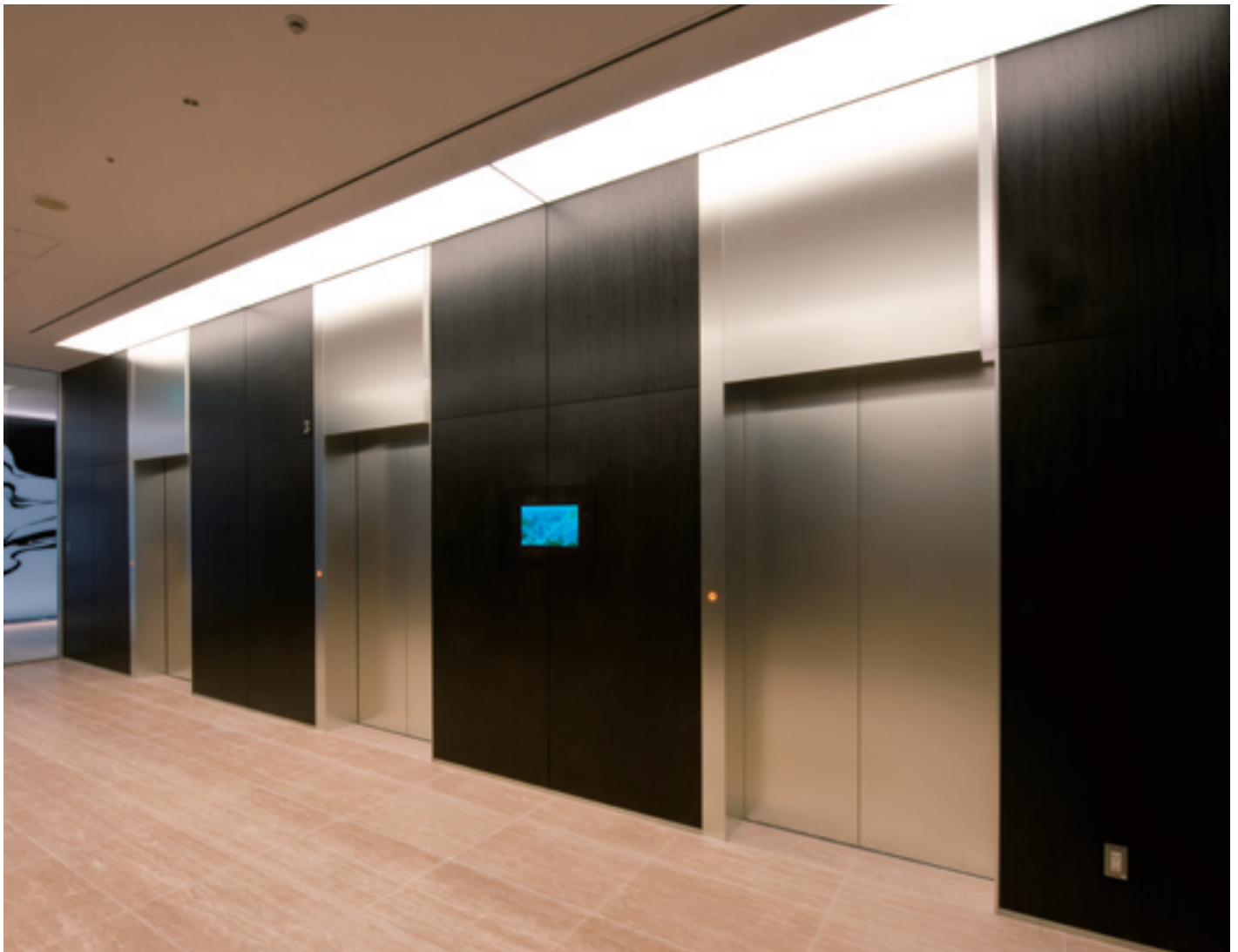
乗用24人乗りダブルデッキエレベーター・3階ホール
