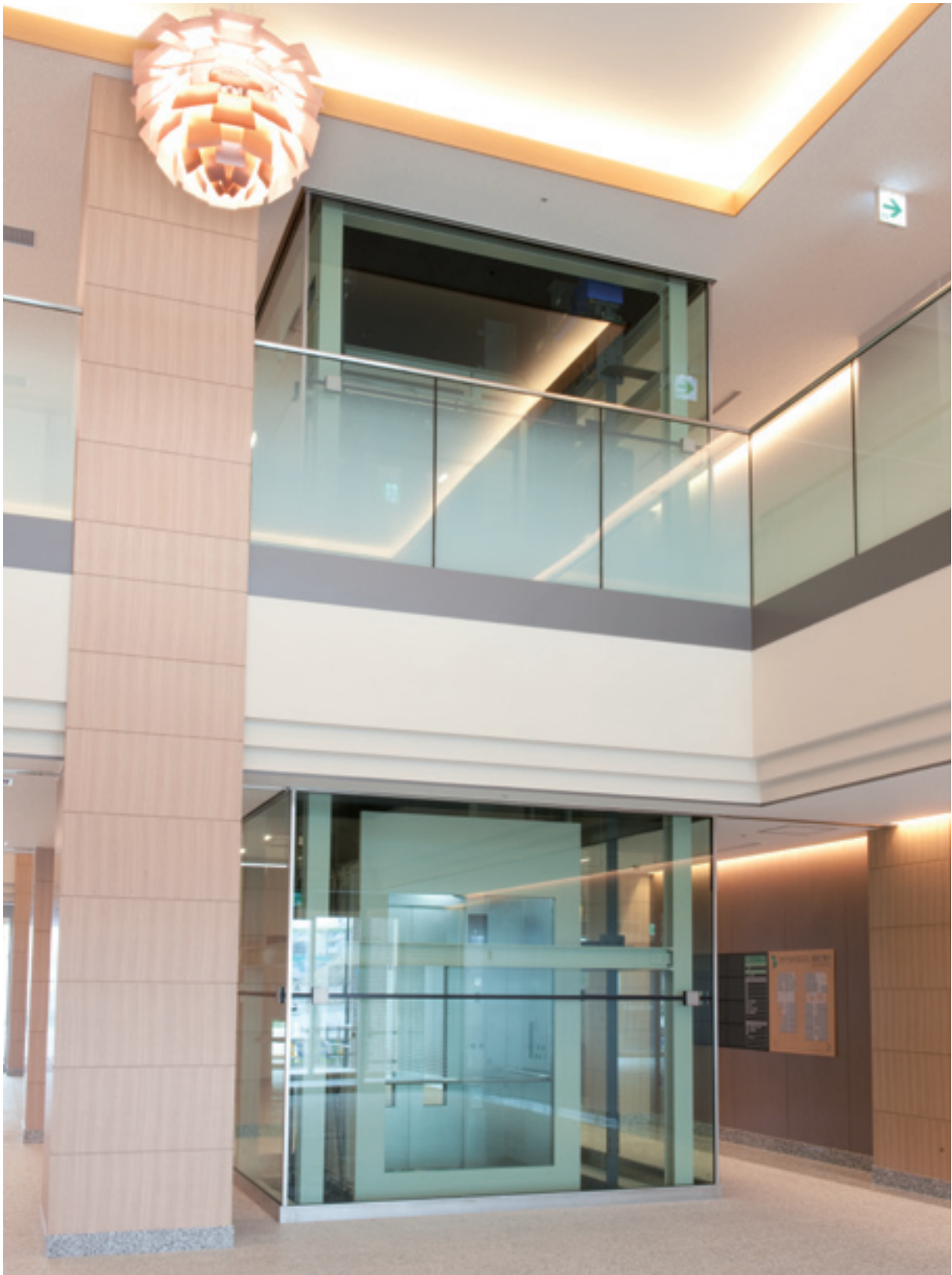
展望用13人乗りエレベーター・昇降路
