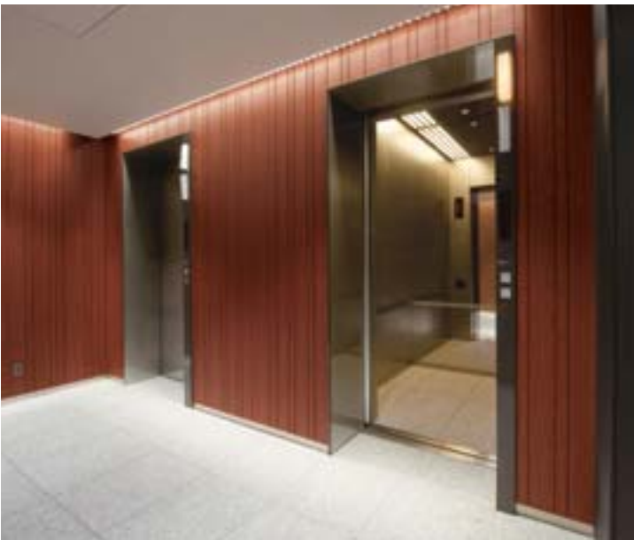
乗用(兼非常用)17人乗りエレベーター・2階ホール
