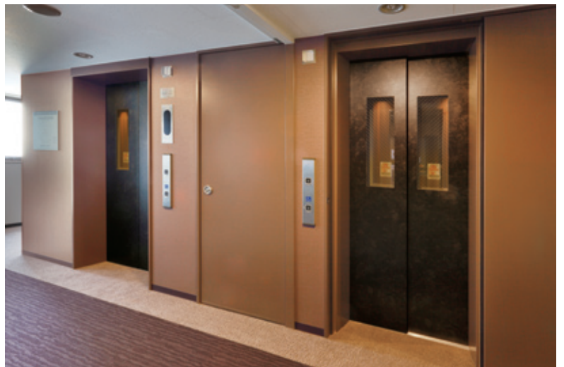
エレベーター・40階ホール(プレミスト琴似スカイクロスタワー)
