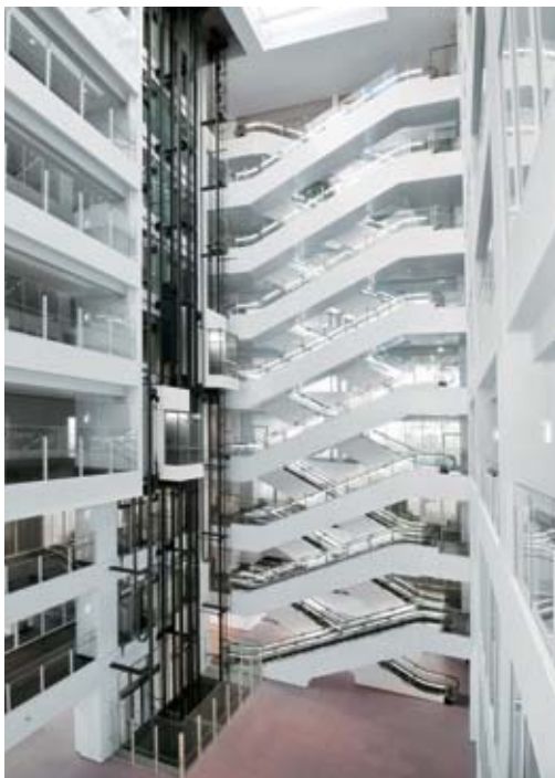
エレベーター／エスカレーター外観
