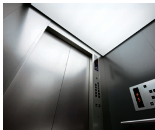
乗用17人乗りエレベーター・かご室天井
