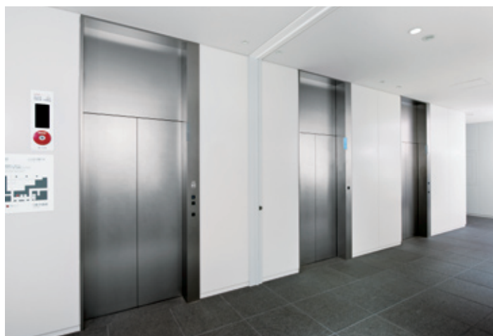
エレベーター・1階ホール
