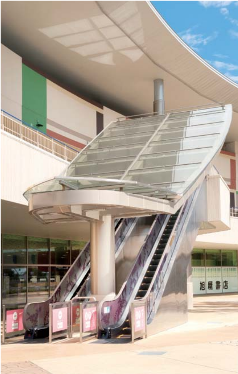
エスカレーター外観(中央エスカレーター)
