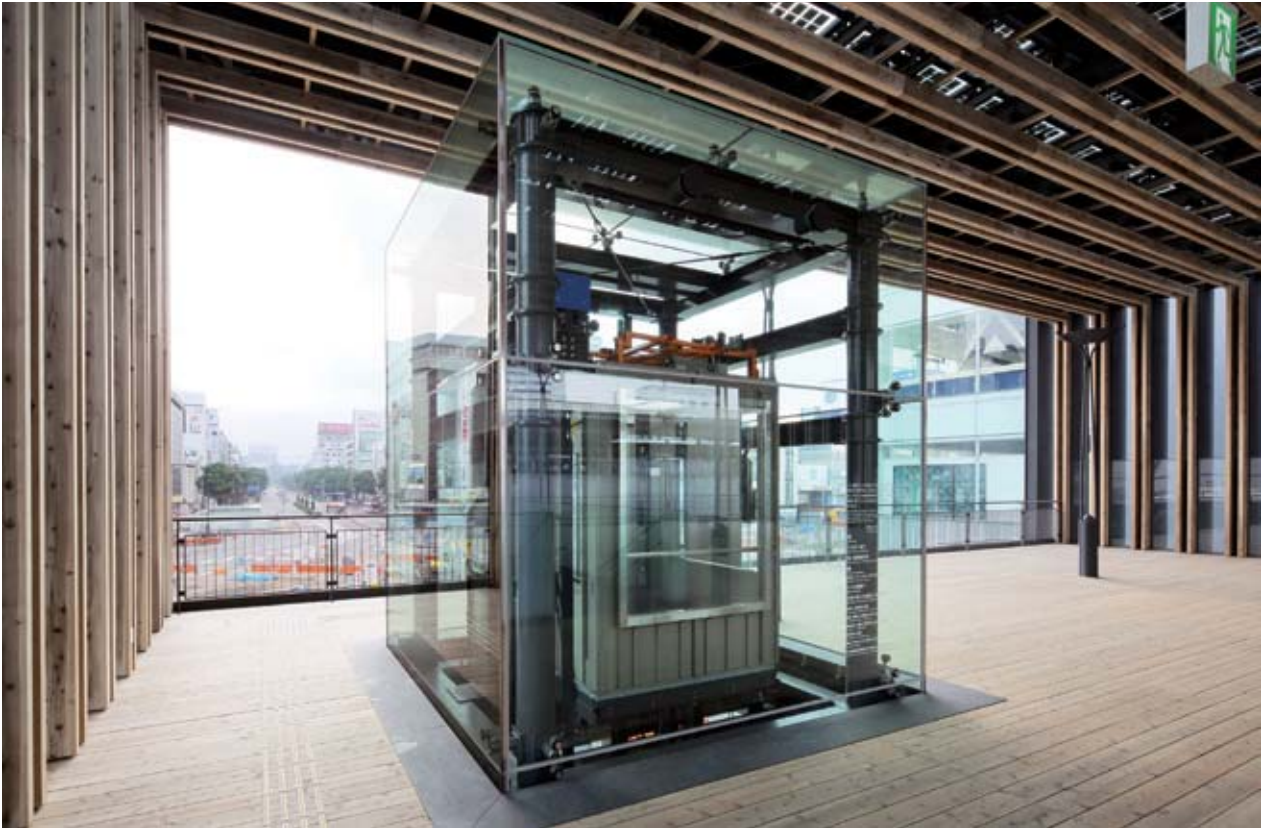
乗用15人乗りエレベーター(眺望デッキ)
