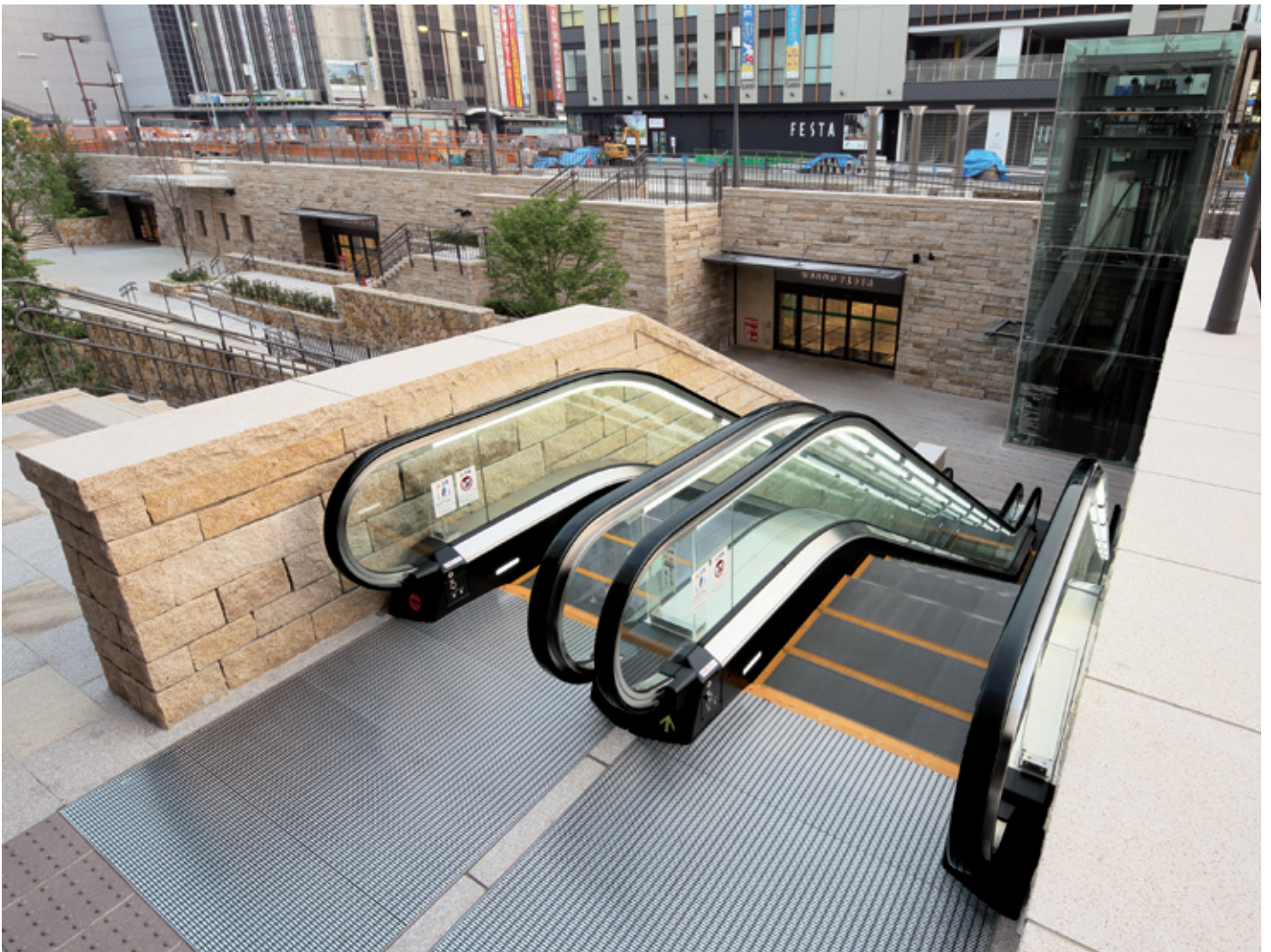
乗用11人乗りエレベーターとエスカレーター(サンクンガーデン)
