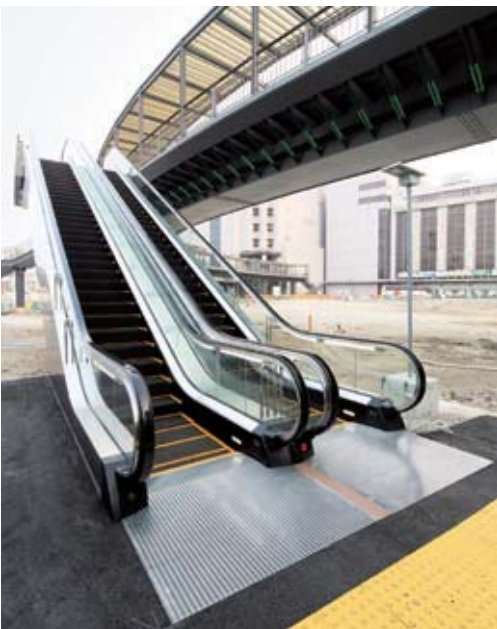
エスカレーター外観(眺望デッキ)
