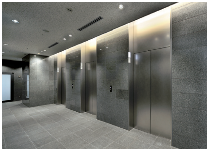
乗用20人乗りエレベーター・2階ホール(ウェストリオ千葉フコク生命ビル)
