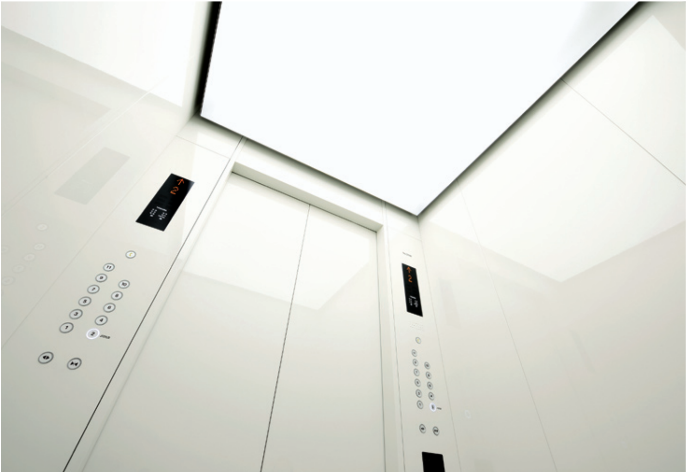
乗用20人乗りエレベーター・かご室天井(ウェストリオ千葉フコク生命ビル)
