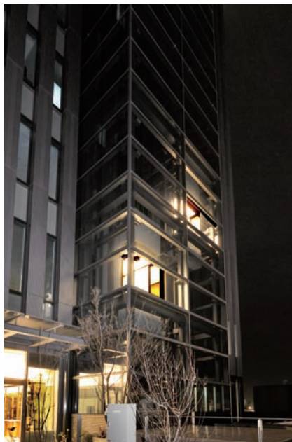
乗用(展望用)24人乗りエレベーター・昇降路外観
