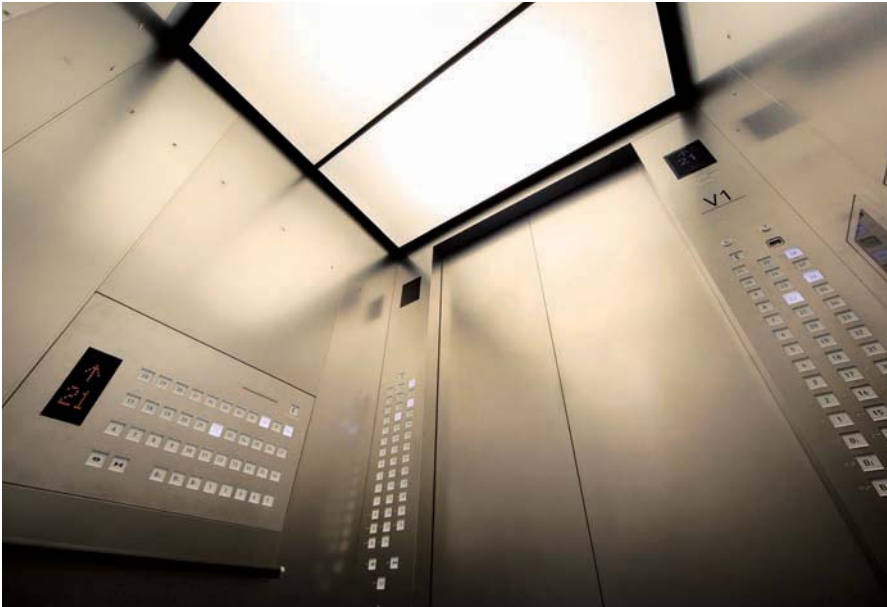
人荷用(兼非常用)17人乗りエレベーター(V1)・かご室天井
