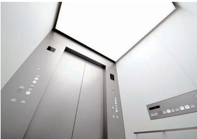
乗用20人乗りエレベーター・かご室天井
