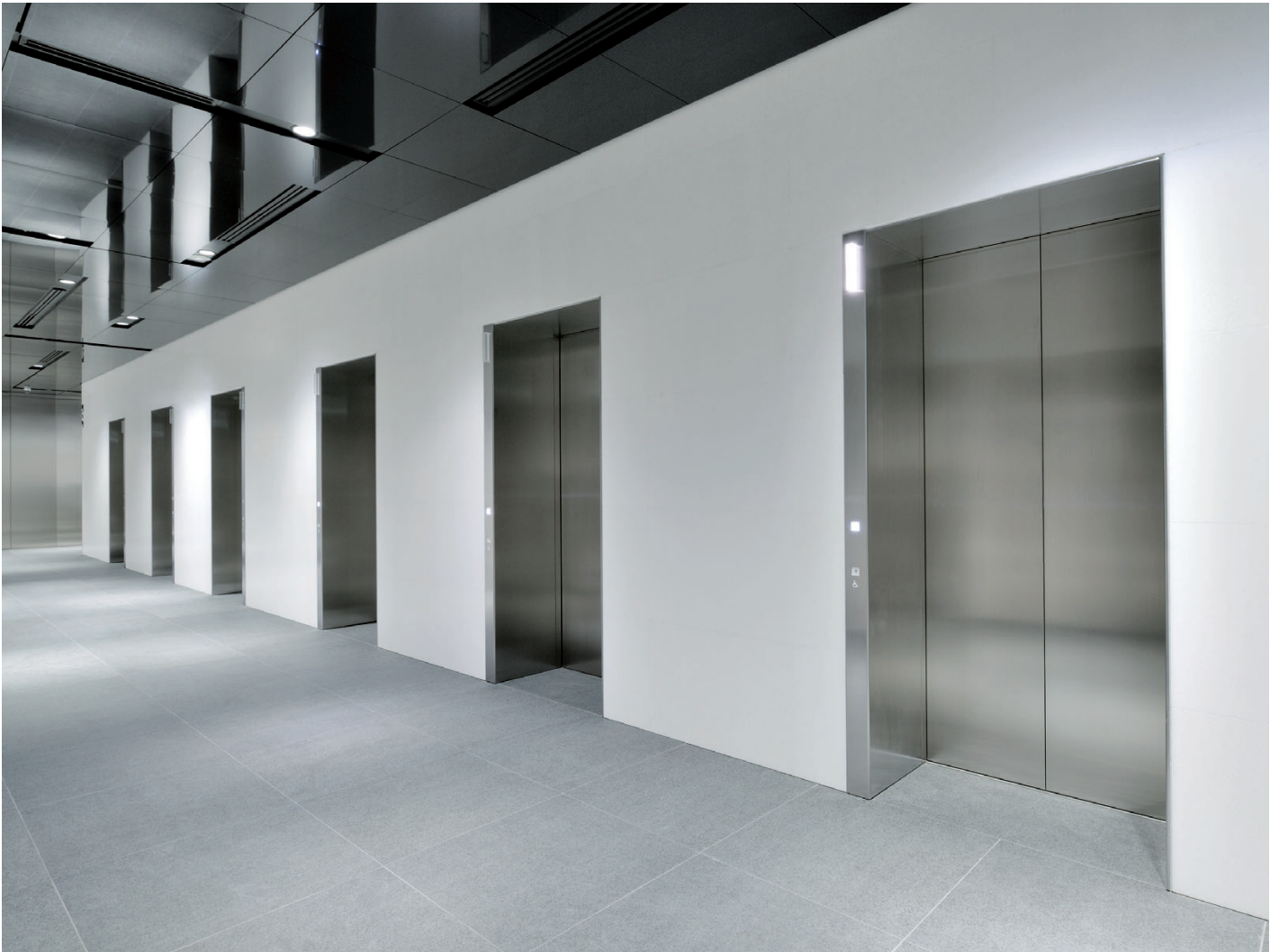
乗用24人乗りエレベーター・3階ホール
