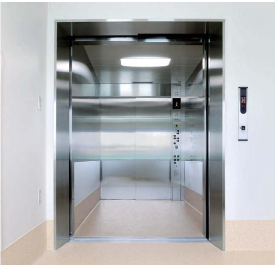
人荷用19人乗りエレベーター・かご室(ヘリポート階のりば)
