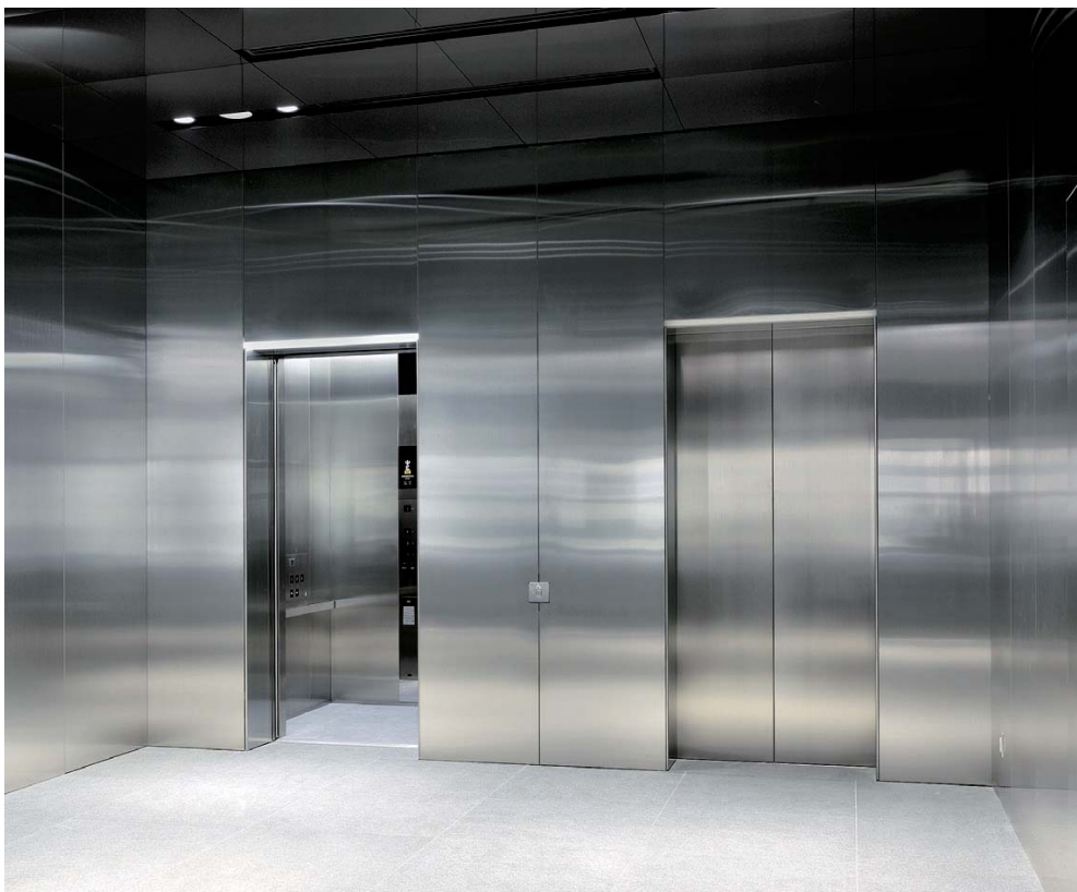
乗用15人乗りエレベーター・3階ホール
