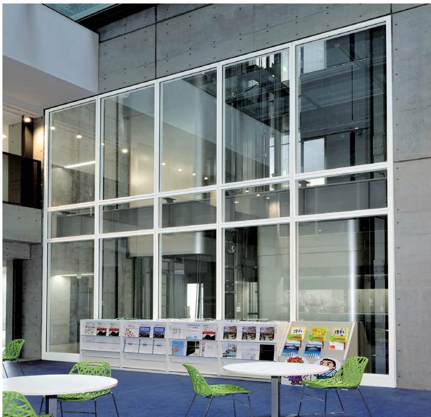
乗用20人乗りエレベーター・昇降路
