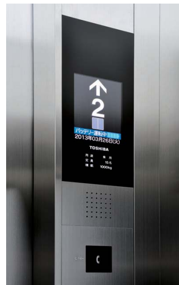
乗用15人乗りエレベーター・トスムープ(停電時継続運転機能)運転表示
