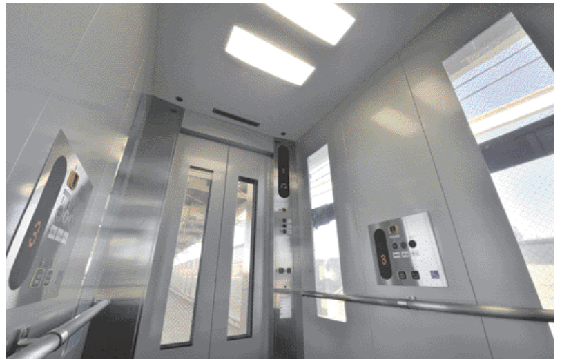
乗用エレベーター・かご室天井
