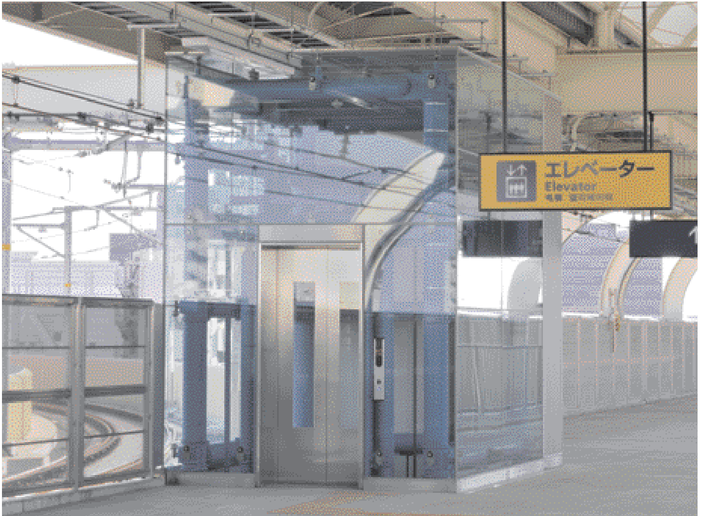
乗用エレベーター・3階ホーム
