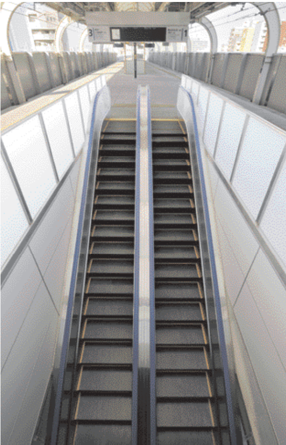
2階ホーム行きエスカレーター(3階ホーム)
