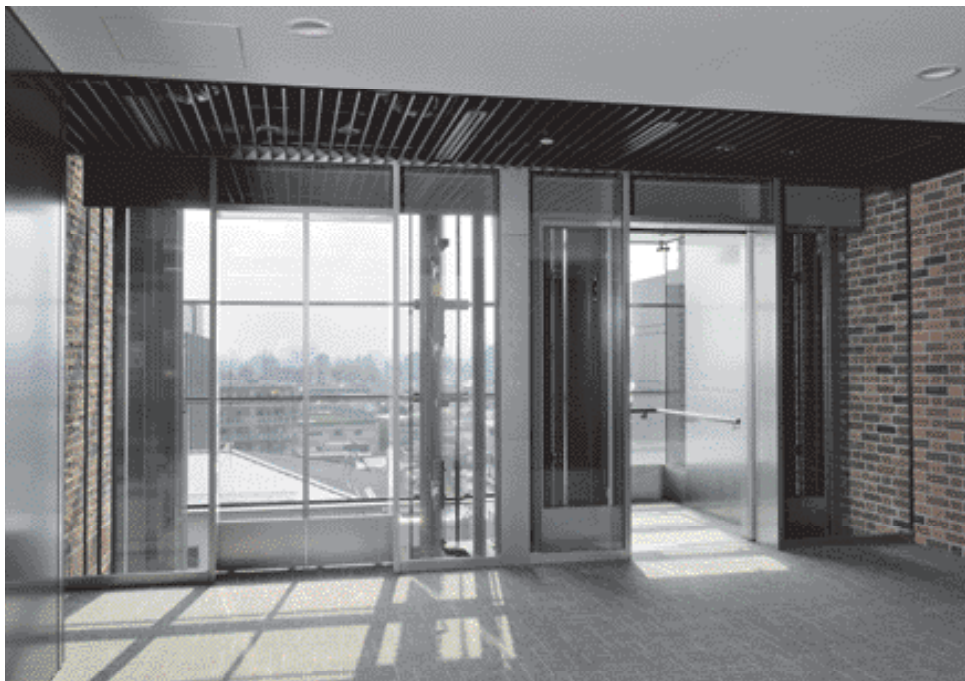
展望用17人／15人乗りエレベーター・7階ホール
