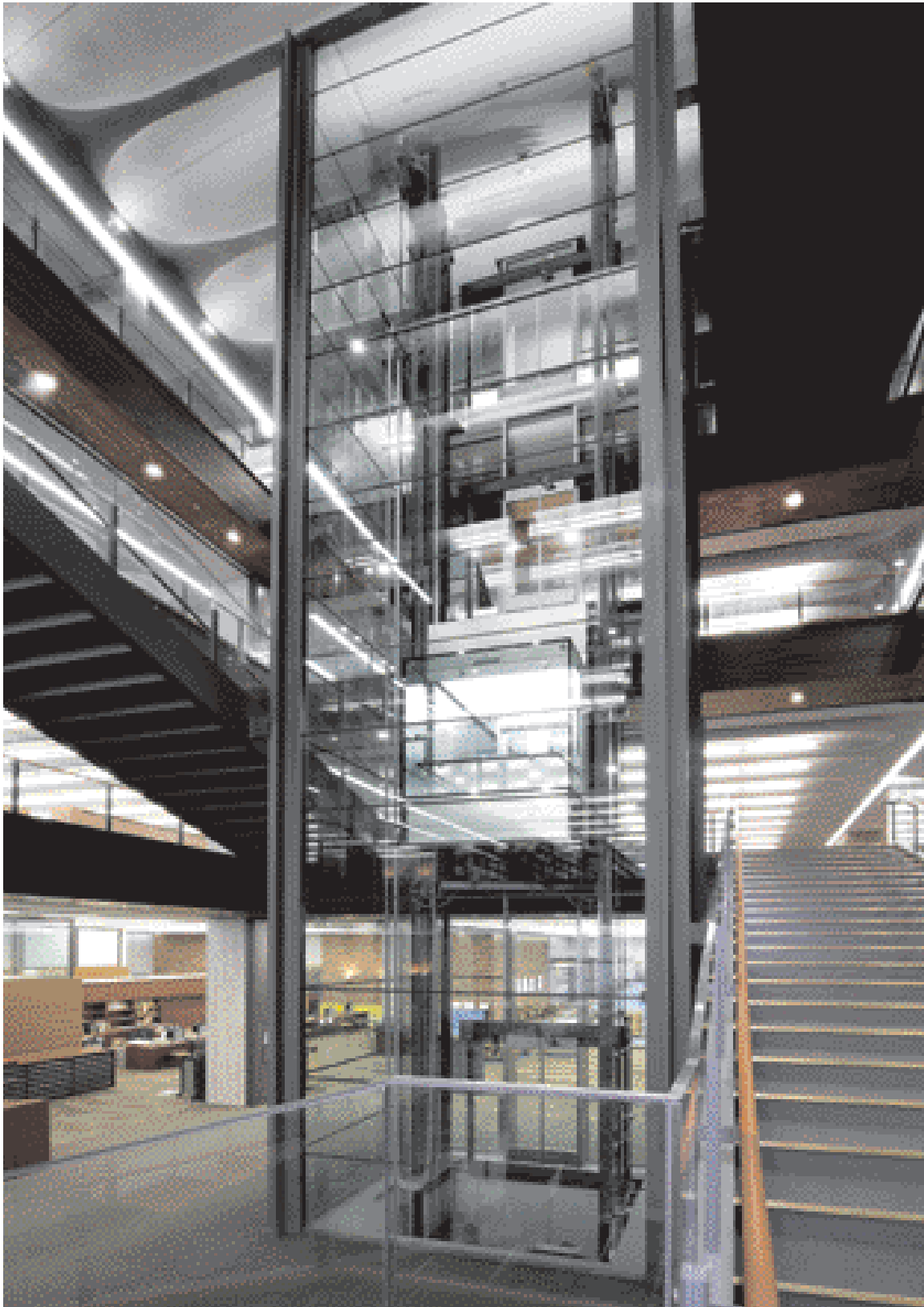
展望用20人乗りエレベーター・外観
