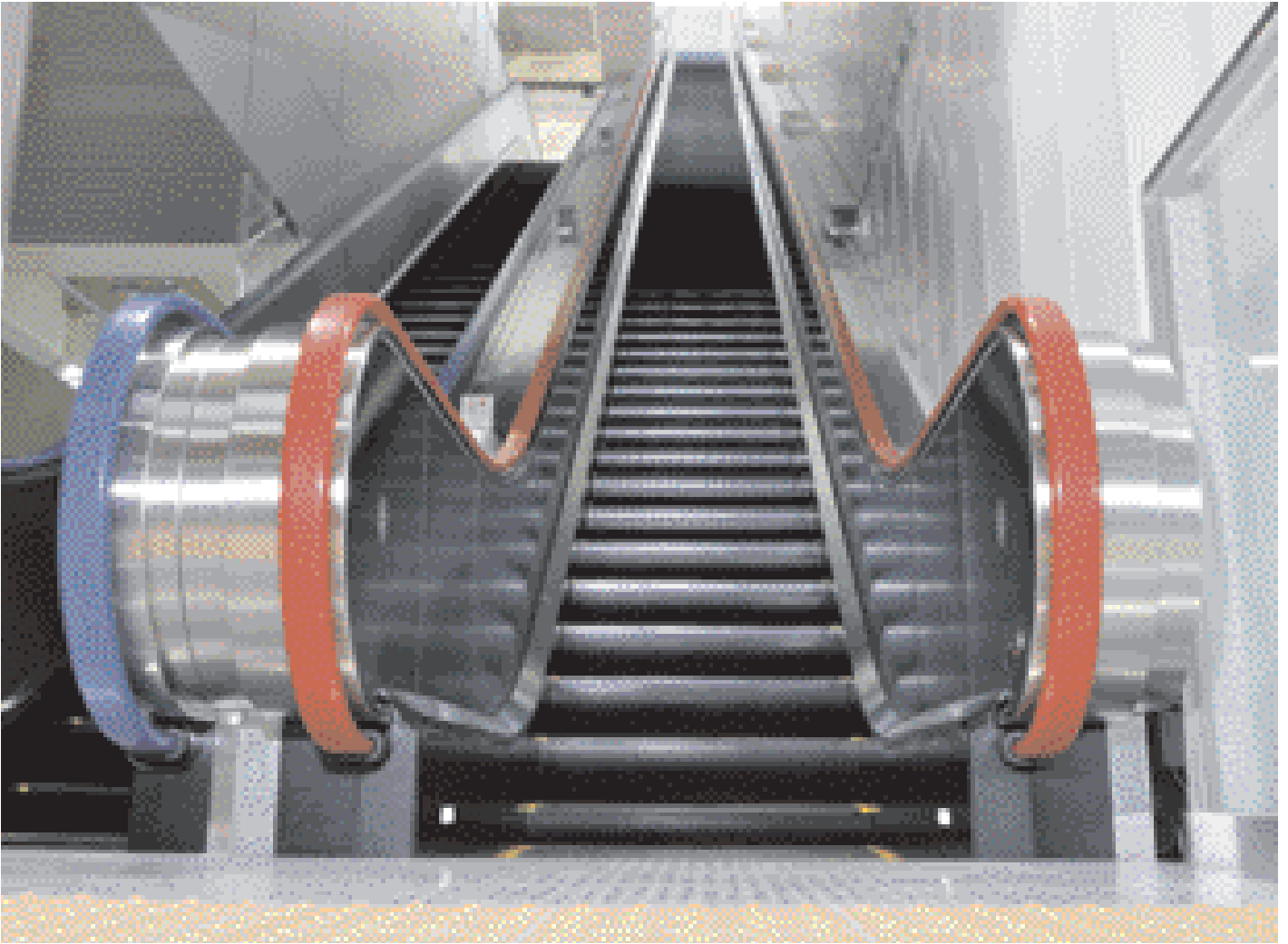
3階ホーム行きエスカレーター(改札階)
