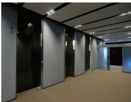
乗用23人乗りエレベーター・2階ホール
