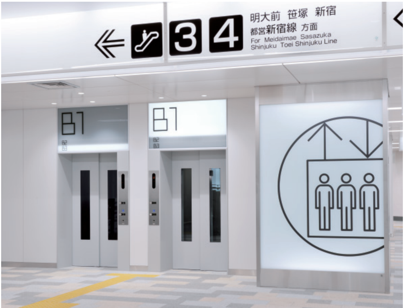
乗用22人乗りエレベーター・地下1階(ホーム行き)
