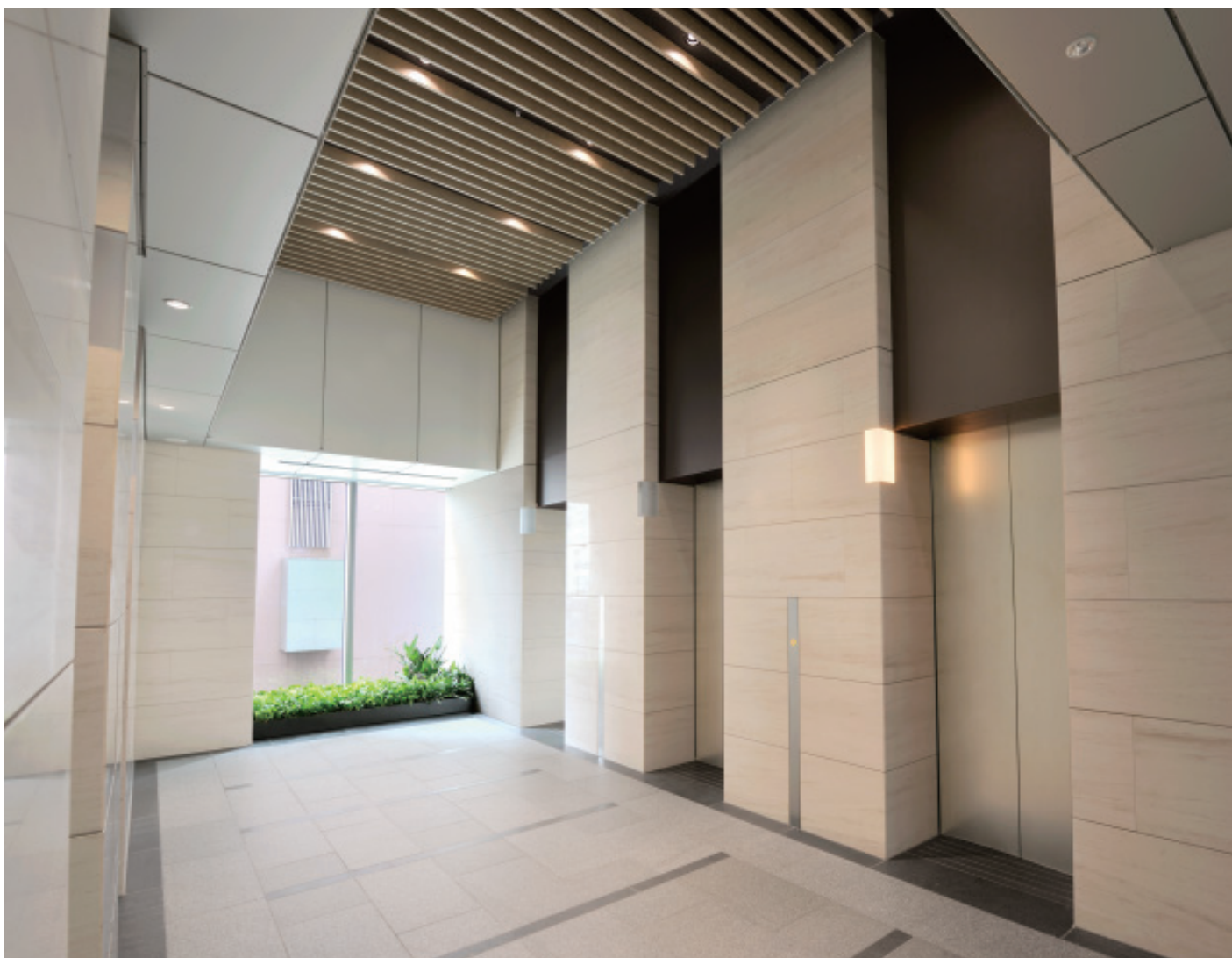
乗用24人乗りエレベーター・2階ホール
