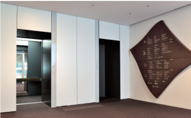
乗用15人乗りエレベーター・3階ホール(東棟)
