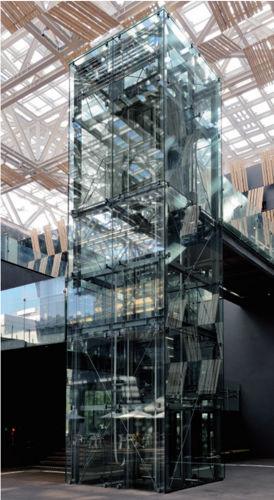
乗用15人乗りエレベーター・昇降路(ナカドマ)
