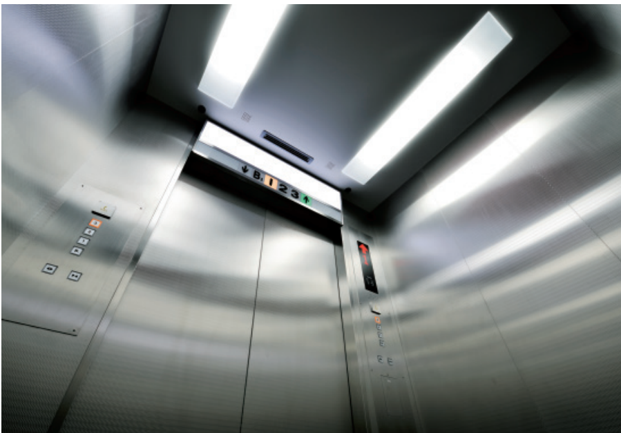
乗用24人乗りエレベーター・かご室天井
