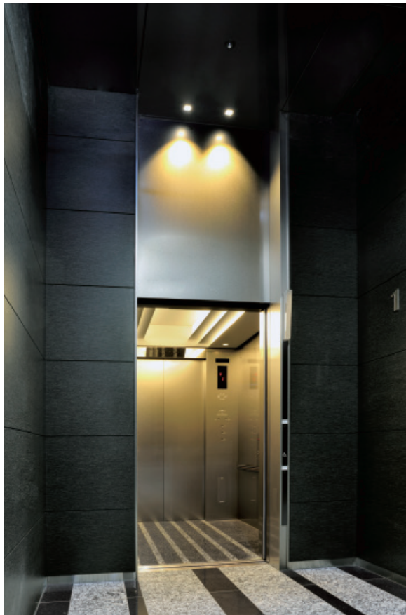
乗用27人乗りエレベーター・かご室(ベルサール渋谷ガーデン)
