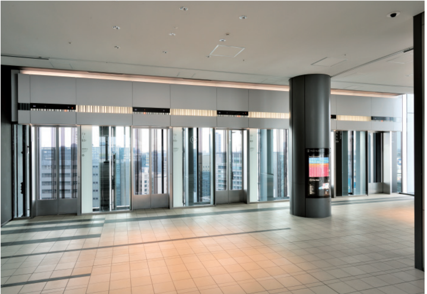
乗用エレベーター・11階ホール
