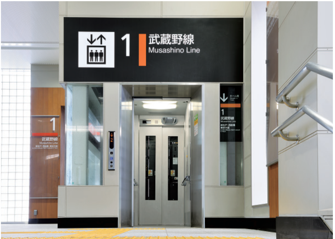
乗用エレベーター(改札階)
