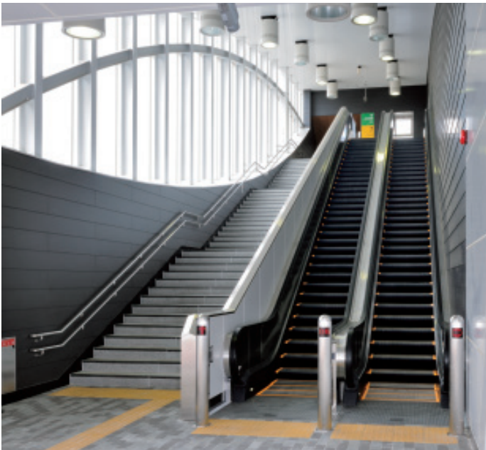
エスカレーター(西口)
