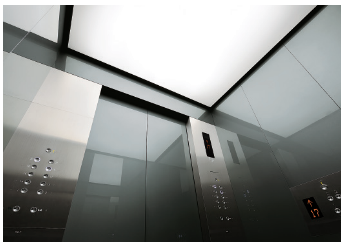
乗用エレベーター・かご室天井
