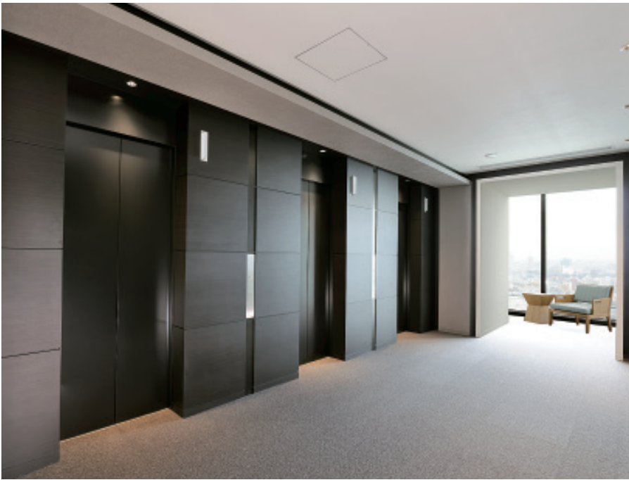
乗用11人乗りエレベーター・32階ホール
