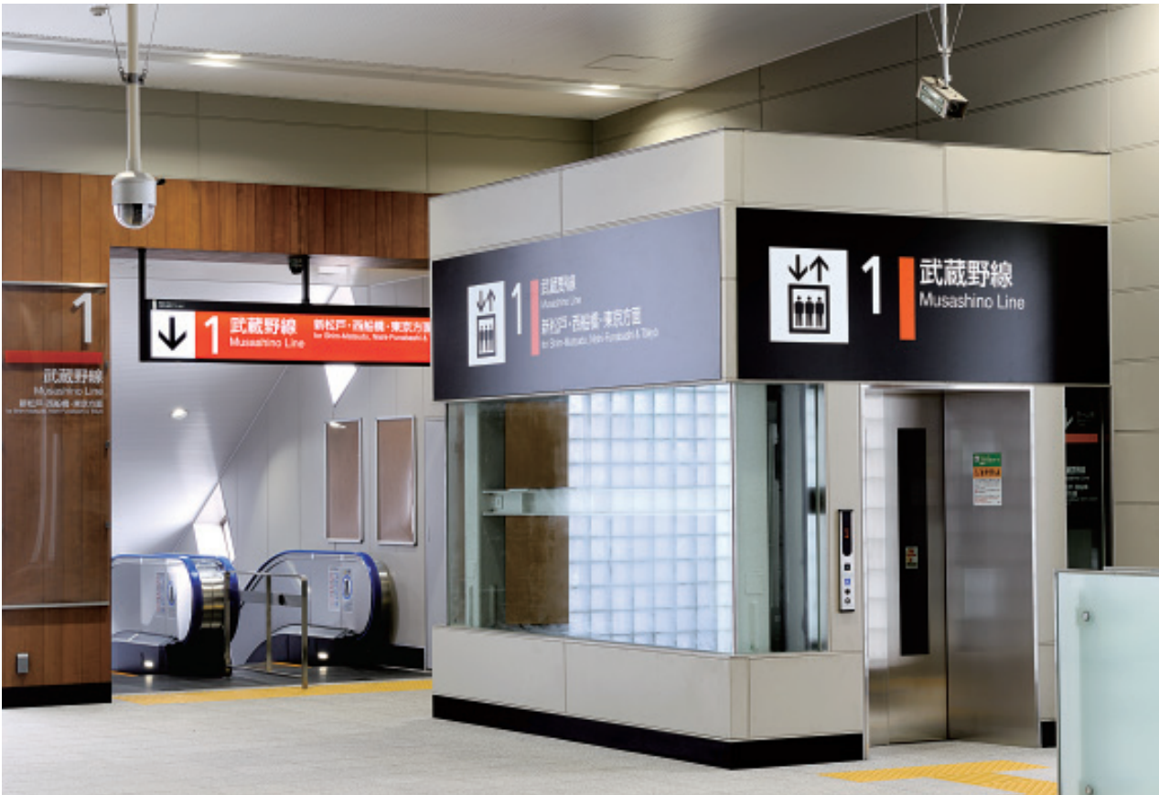
乗用エレベーターとエスカレーター(改札階)
