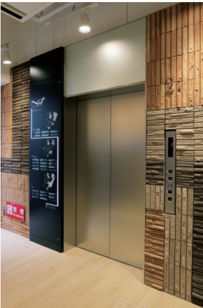
展望用エレベーター・昇降路
