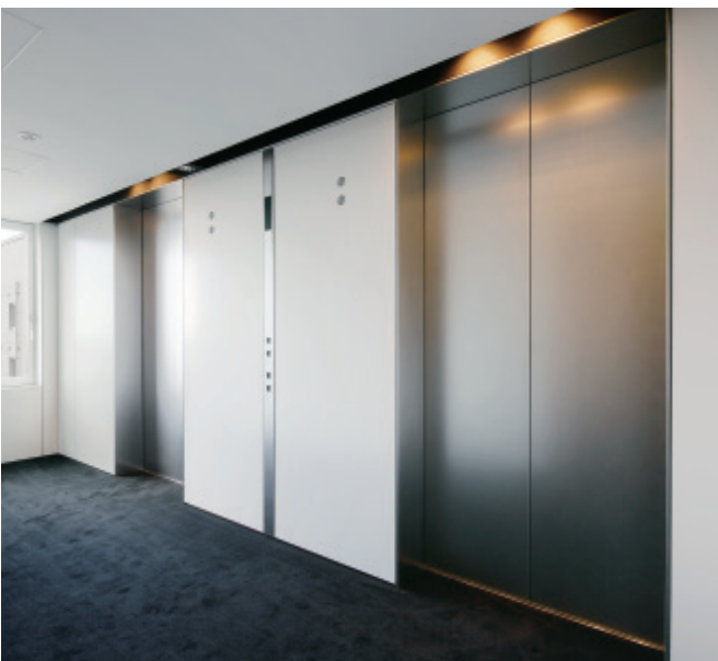
乗用エレベーター・8階ホール
