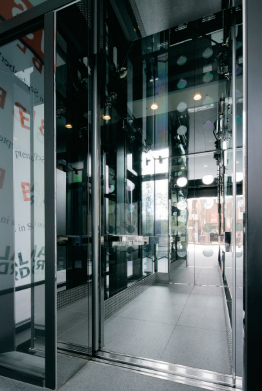
展望用エレベーター・かご室(前後両開きシースルーエレベーター)
