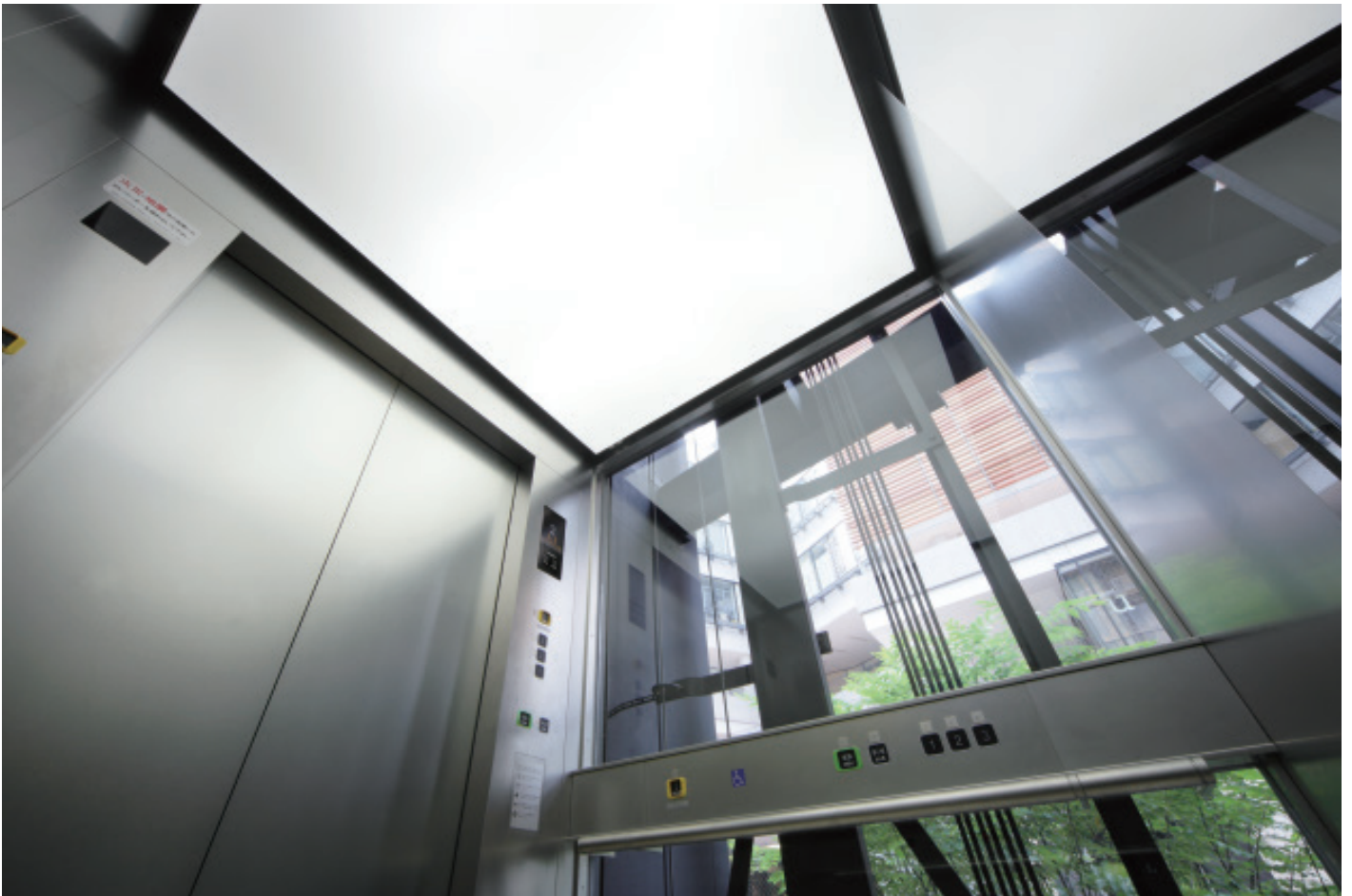
展望用エレベーター・かご室
