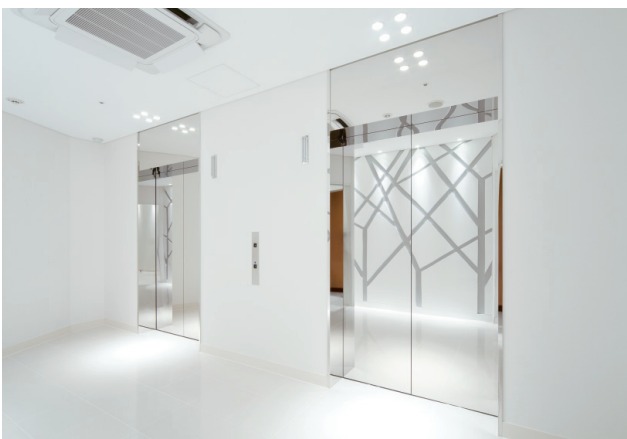
乗用エレベーター・8階ホール
