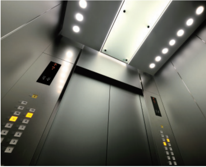
乗用エレベーター・かご室天井 (N棟)
