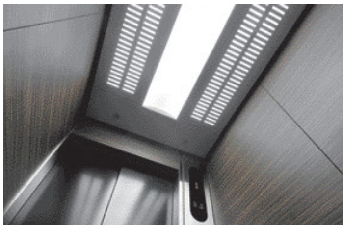
乗用エレベーター・かご室天井(上大岡タワー ザ レジデンス)
