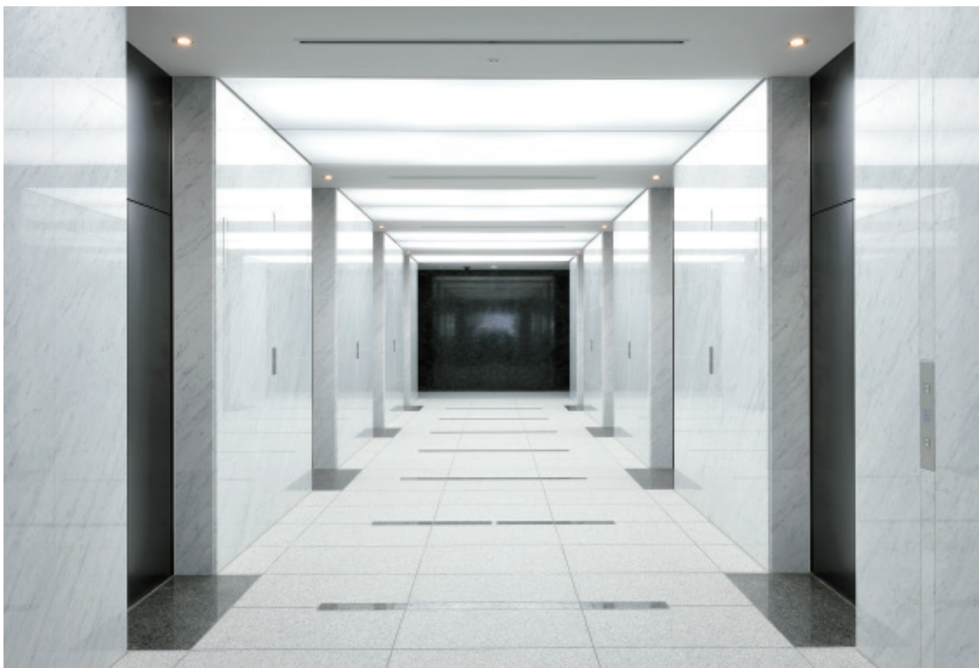
乗用エレベーター・1階ホール(ウエスト2棟)
