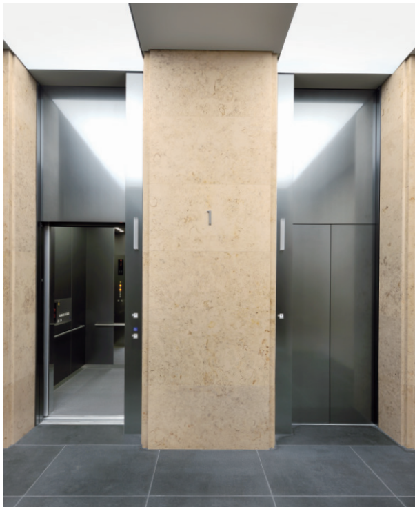
乗用エレベーター・1階ホール (S棟)
