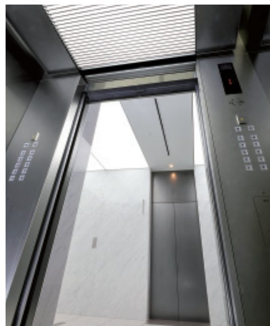
乗用エレベーター・かご室天井(ウエスト2棟)
