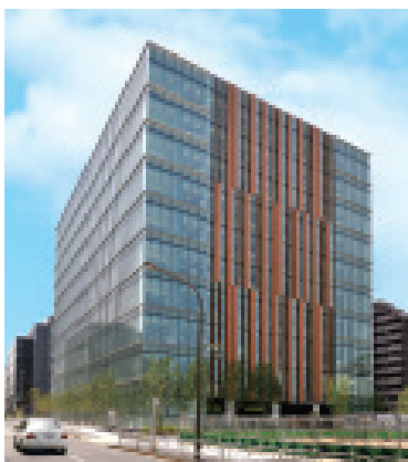
建物外観(ウエスト3棟)
