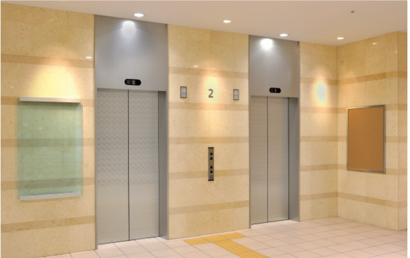
展望用エレベーター・2階ホール (mioka)
