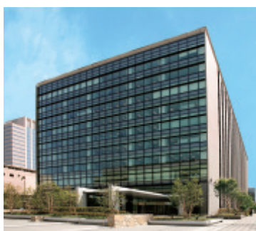
建物外観(ウエスト2棟)
