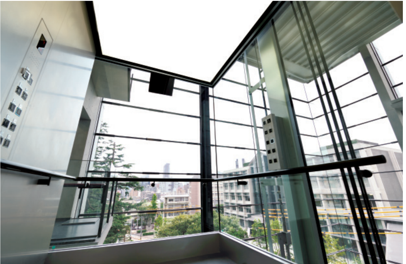
展望用エレベーター・かご室
