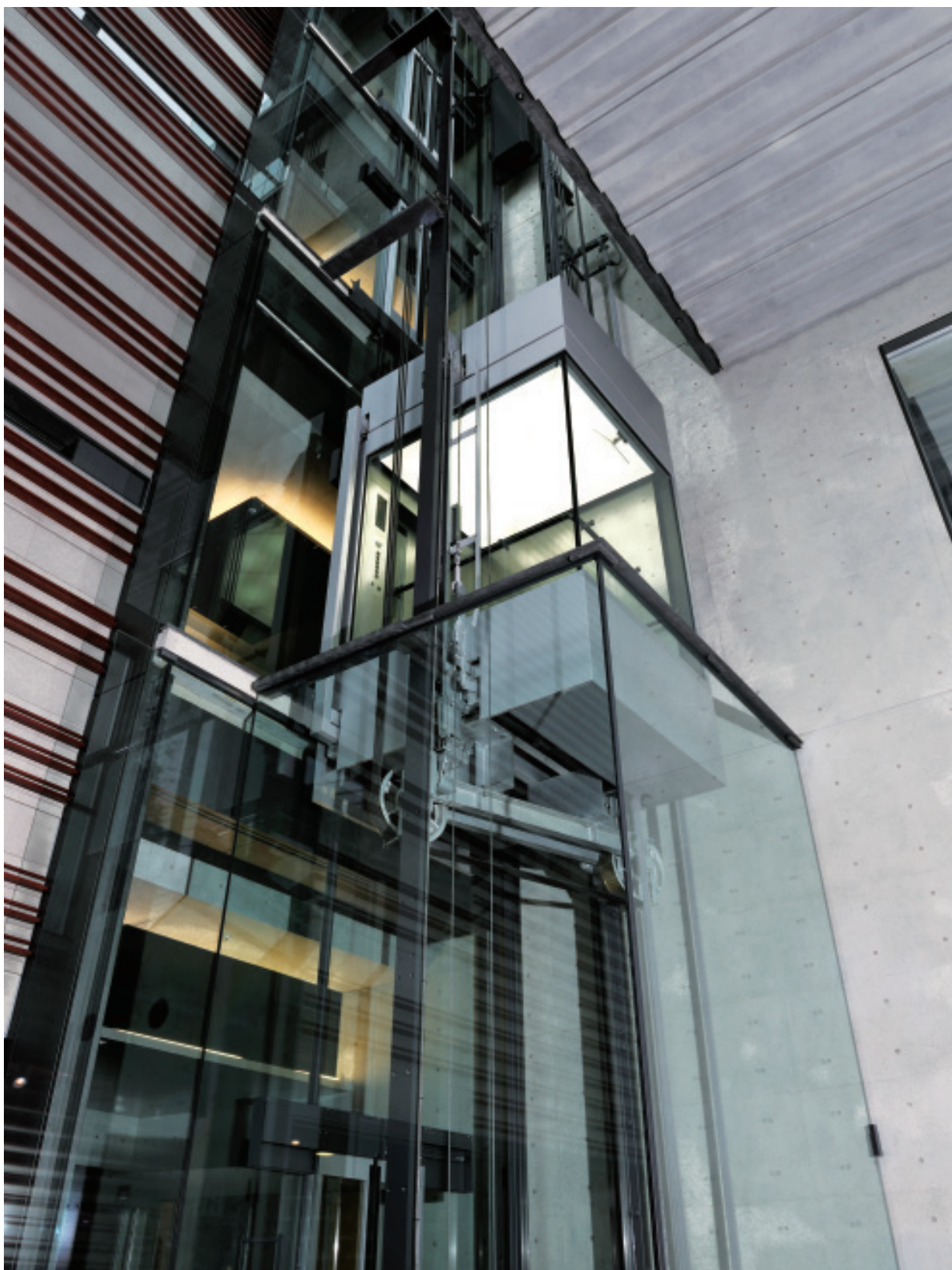
展望用エレベーター・外観
