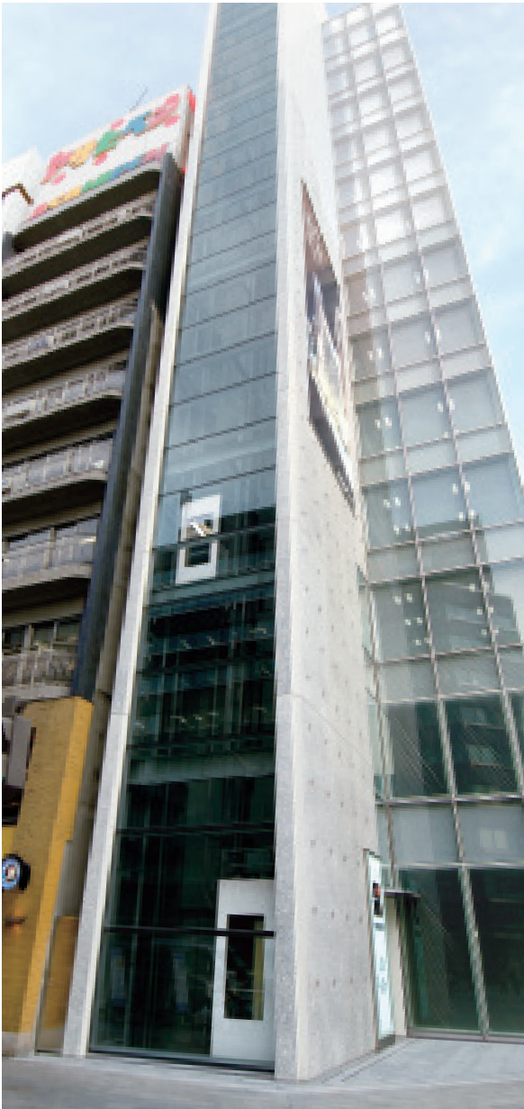
展望用エレベーター・外観
