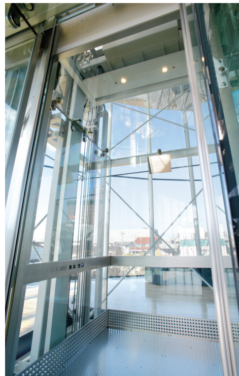
展望用エレベーター・かご室
