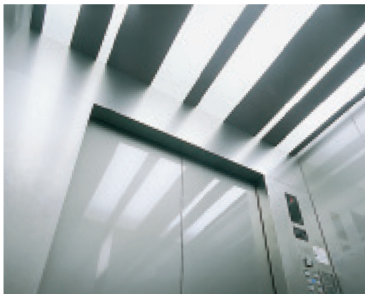
乗用 24 人乗りエレベーター・かご室天井
