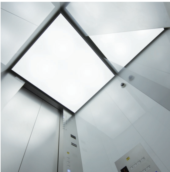
エレベーター・かご室
