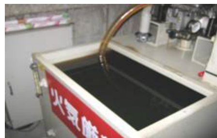
劣化が進んだ作動油の例
