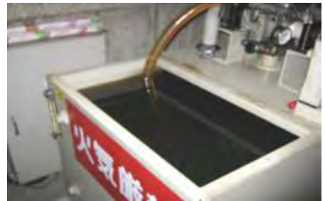
劣化が進んだ作動油の例 酸化が進み作動油が変色
