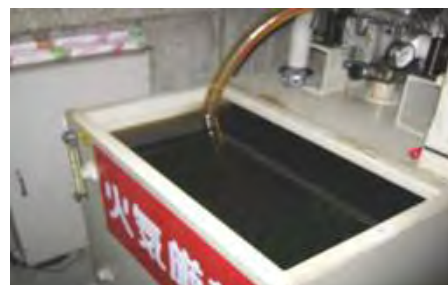
劣化が進んだ作動油の例
