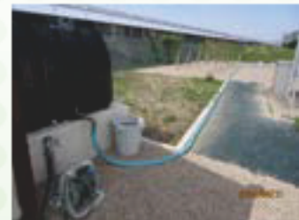
雨水貯水タンク (ビオトープ池で使用)
