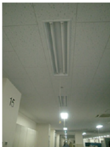
執務エリアの照明の簡引きを実施
